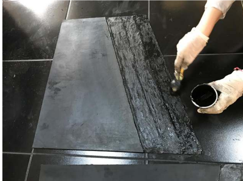
Şekil 7.25. Soğuk vulkanize yapıştırıcının konveyör bantlara uygulanması.
