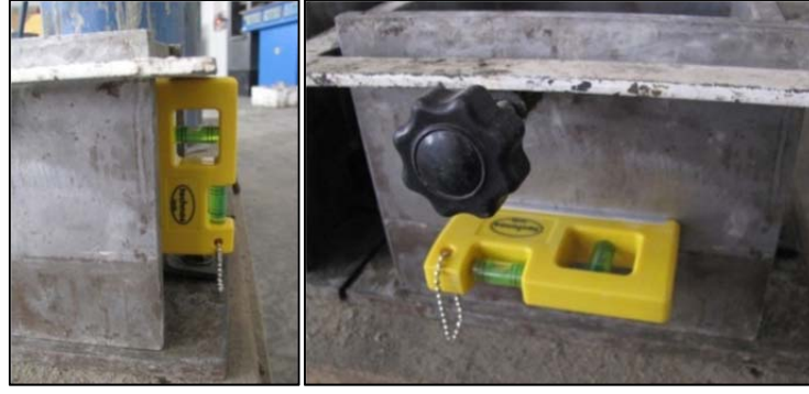
Şekil 3.6. Kalıp şakülünün kontrolü
