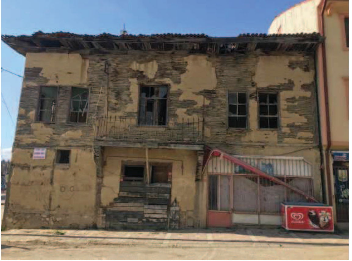
Fotoğraf 11: Muazzez Manzeoğlu Evi güney cephesi
