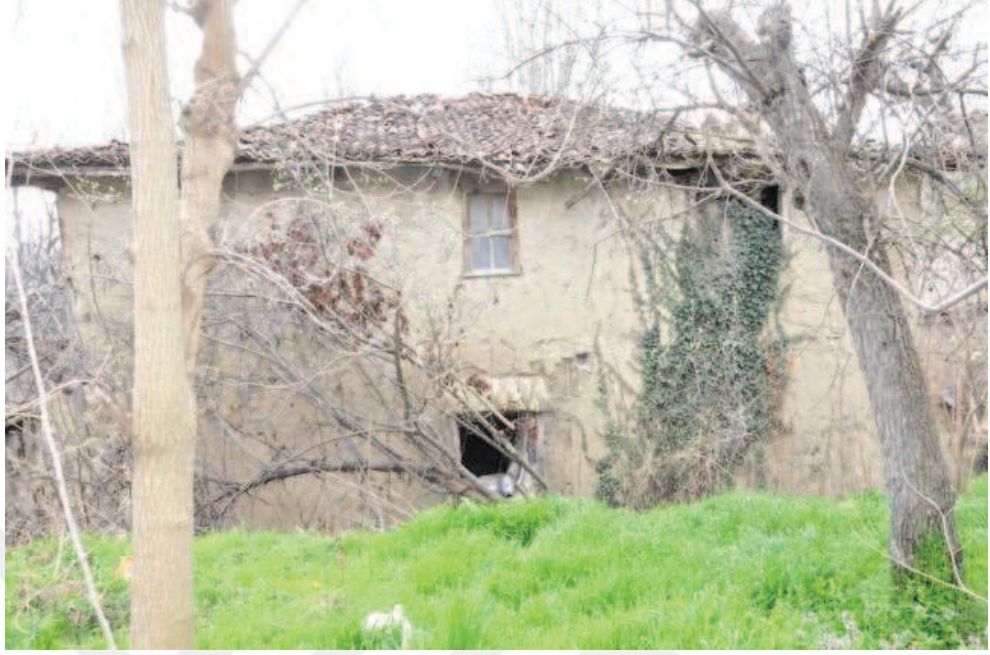
Fotoğraf 109: Osman Kayacık Evi arka cephe
