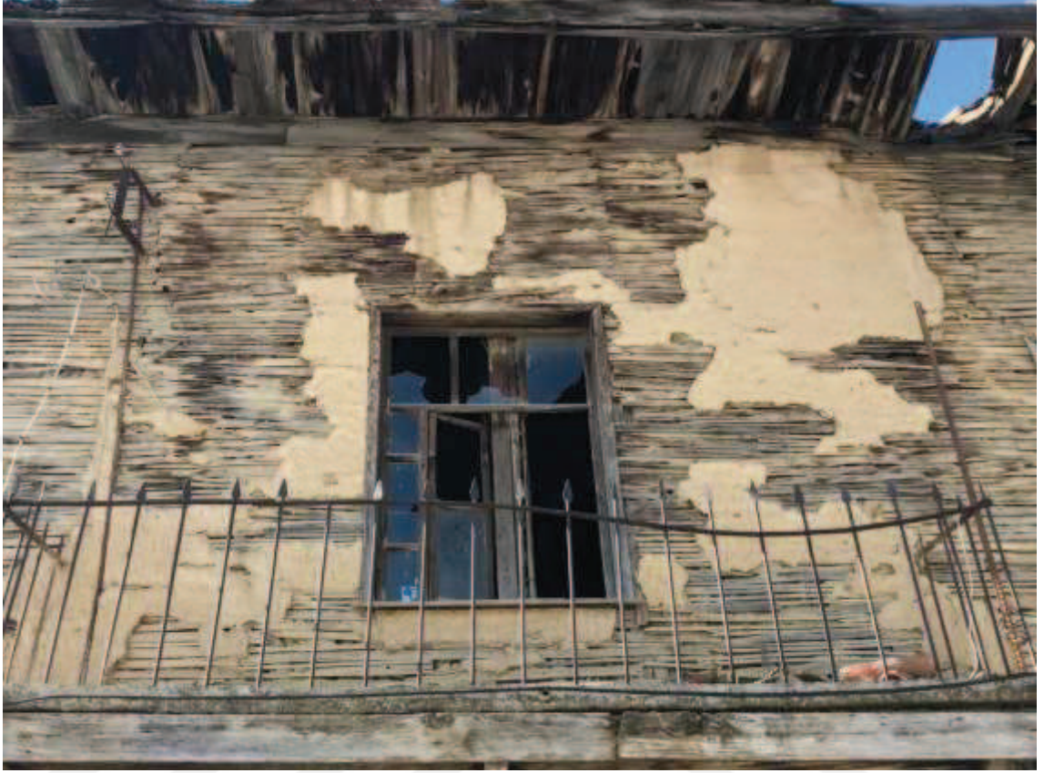
Fotoğraf 14: Muazzez Manzeoğlu Evi bağdadi duvar tekniği
