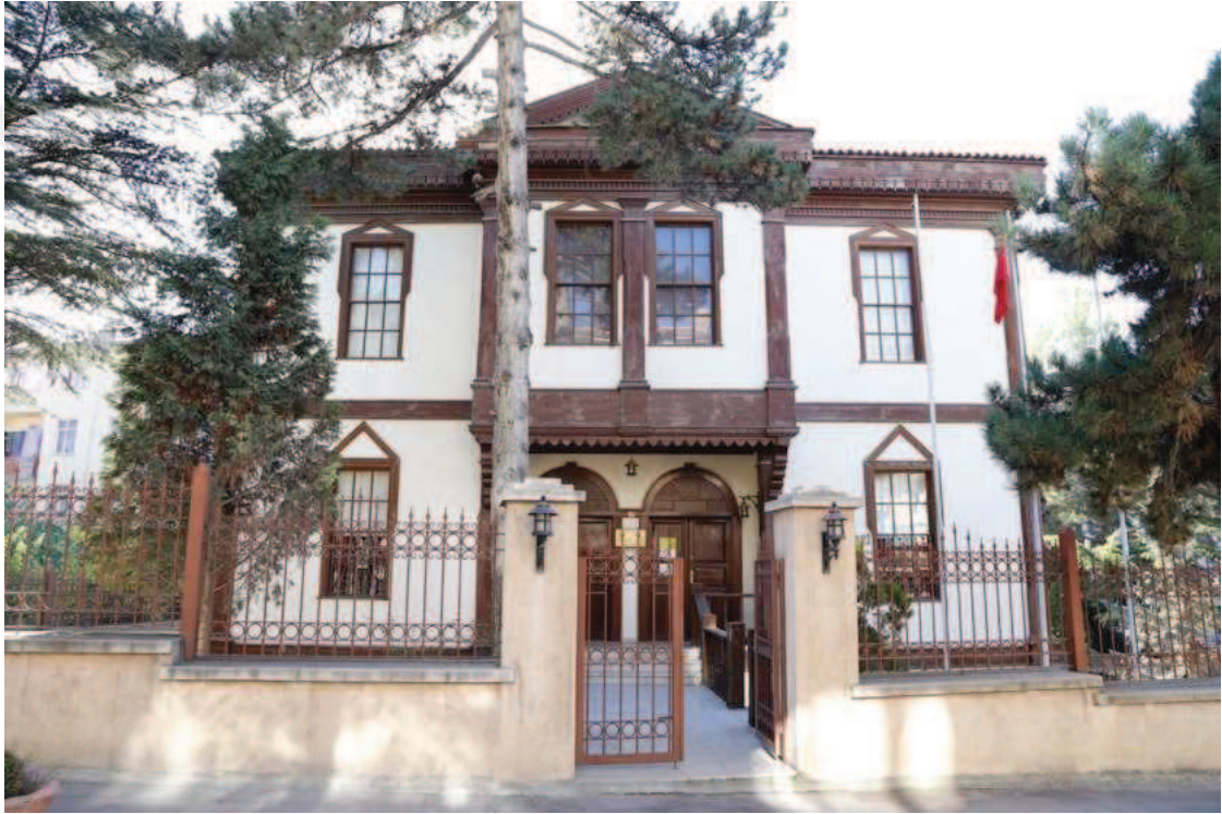
Söğüt Müzesi'nin ön cephesi
