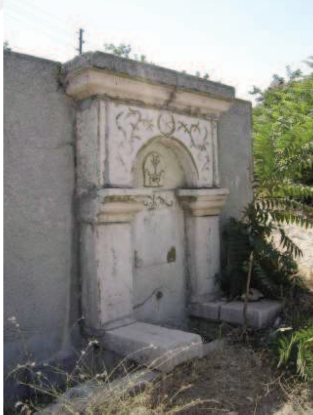
K.F. 67: Pelitözü Köyü Çeşmesi
