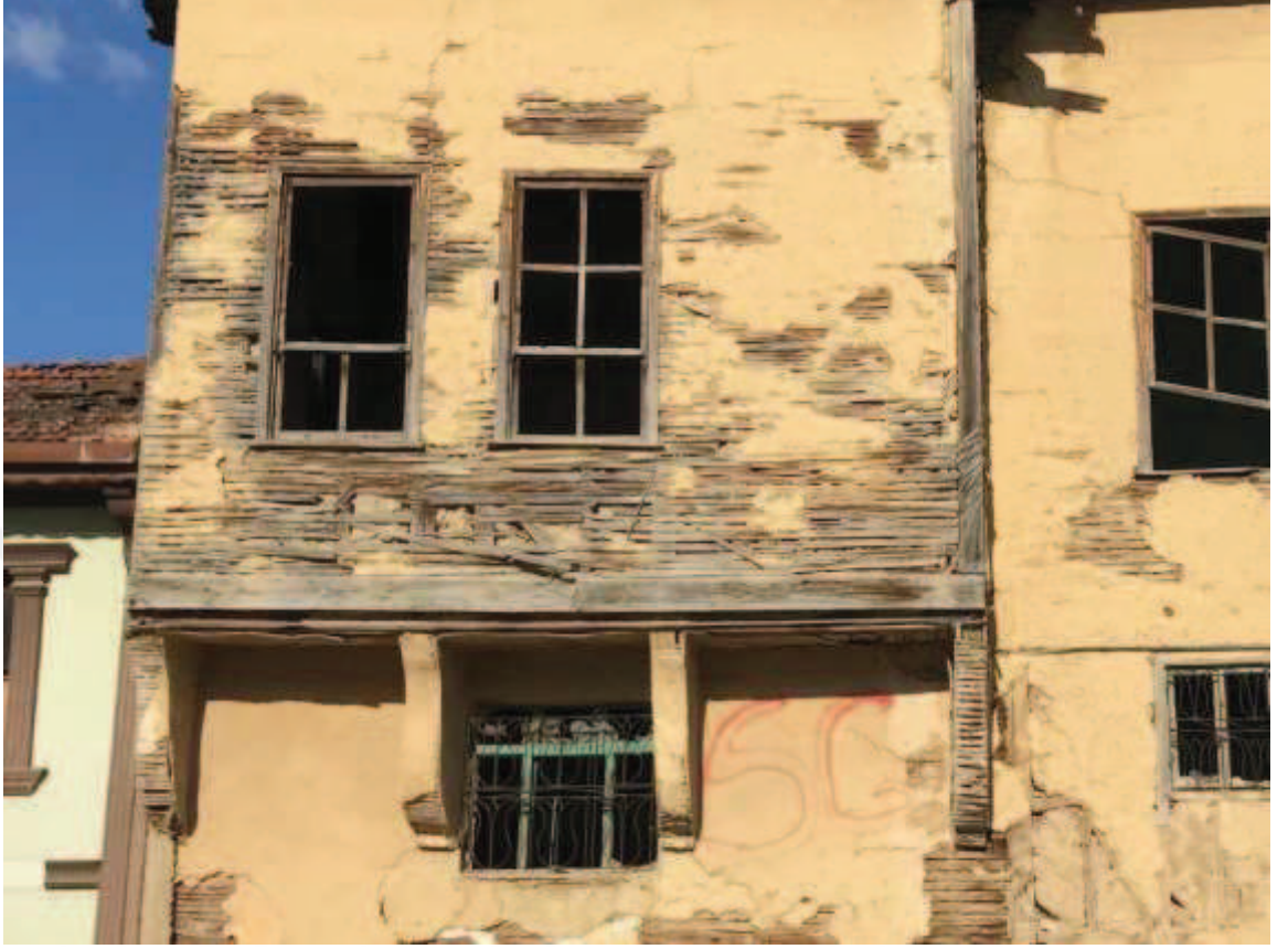
Fotoğraf 15: Muazzez Manzeoğlu Evi eliböğünde kullanımı
