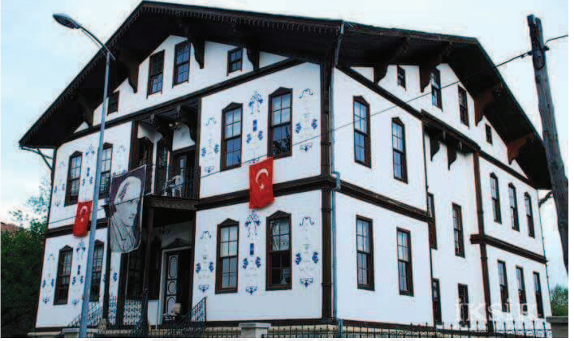
K.F. 75: Kastamonu Daday Hükümet Konağı
