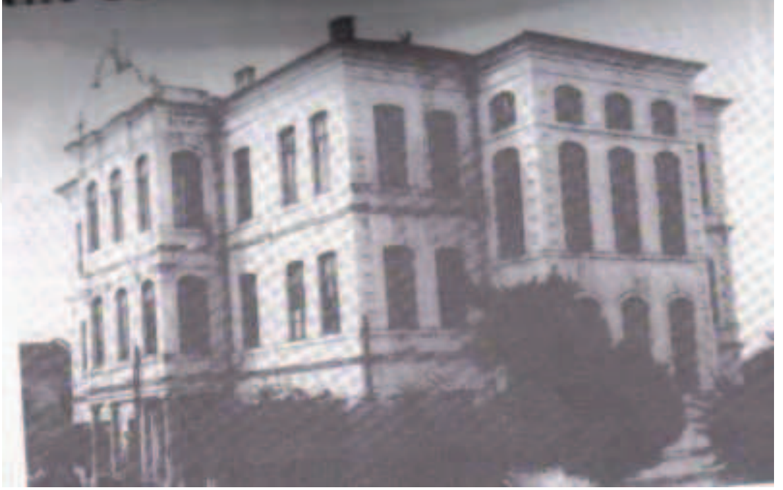
Bartın Hükümet Konağı
