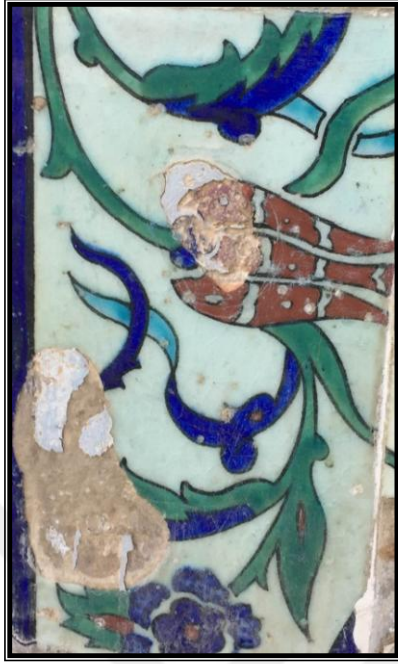
Resim 122, Şekil 152 Kaymakam Sait Bey Çeşmesi Doğu Yönü 93. Karo ve Restitüsyon Çizim (Burak ÜNER-22.05.2020-Bursa-TÜRKİYE)
