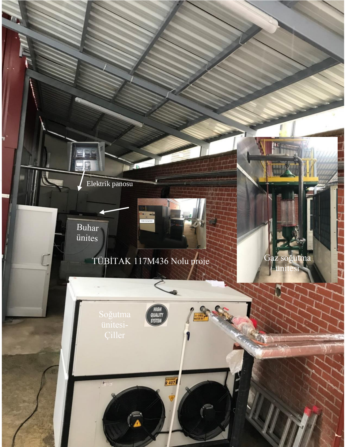
Şekil 4. Gazlaştırma sistemi elemanları
