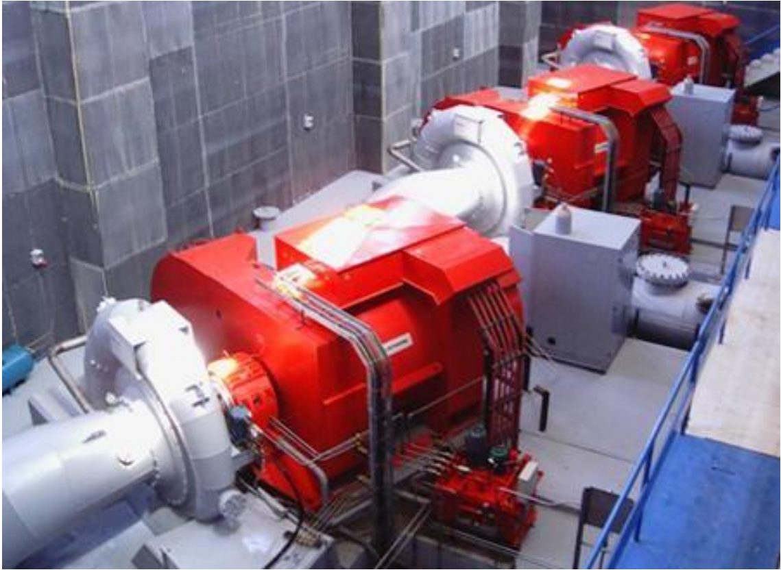
Şekil 7. Türbin-jeneratör grupları.
