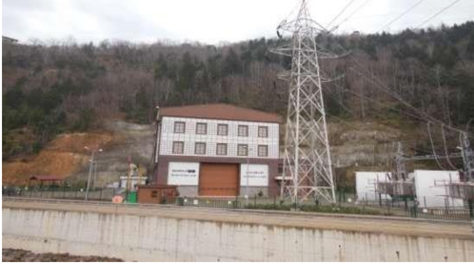
Şekil 24. Çambaşı santral binası (23.12.2017).
