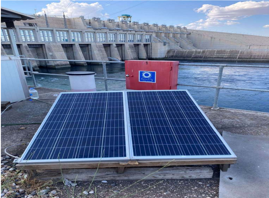
Şekil 5.11 Kurulumu Yapılan Panellerin Önden Görünümü
