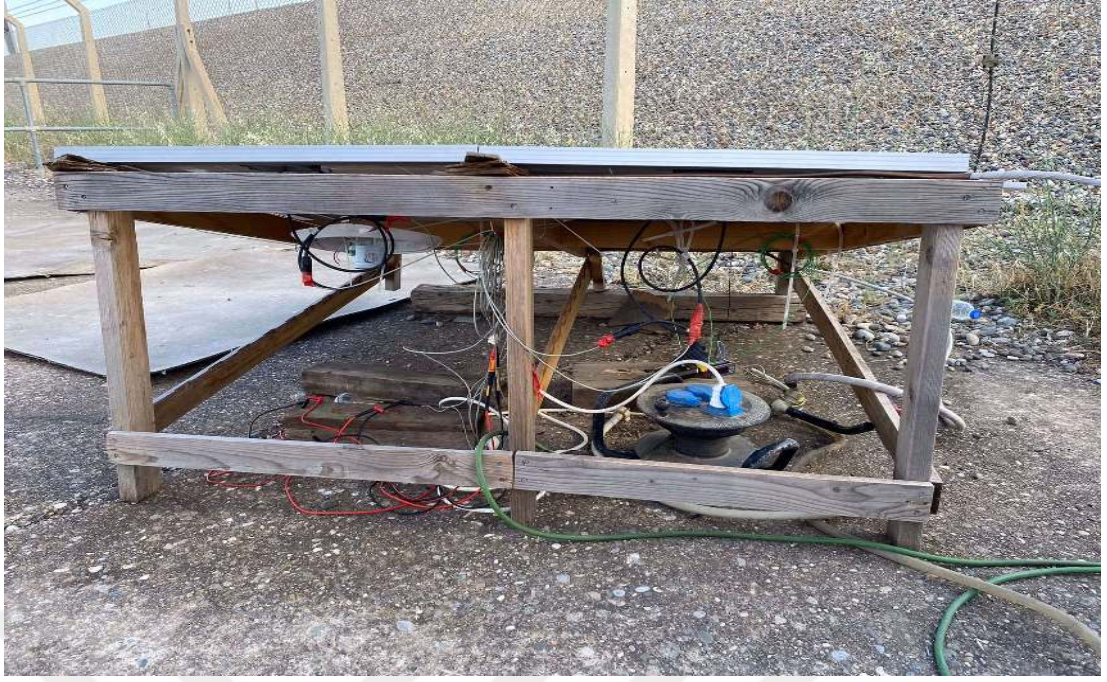
Şekil 5.12 Kurulumu Yapılan Panellerin Arkadan Görünümü
