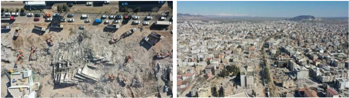
Görsel 5.18. Şehir Fotoğrafi, 2024, Drone-Fotoğraf: Ömer Faruk Gözleyici, SBKP arşivinden (İlgili Proje Arşivi: bit.ly/44dw1e0 )
