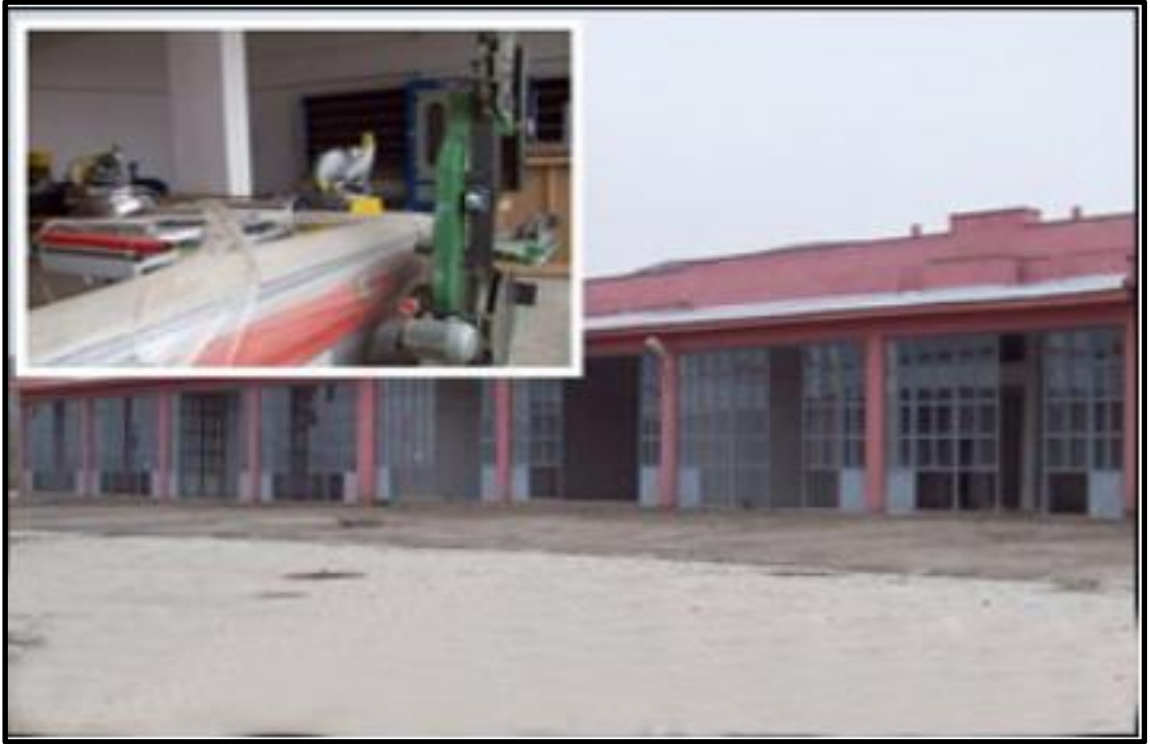
Foto 9: Solhan(Bingöl)Küçük Sanayi sitesinden Bir Görünüm.
