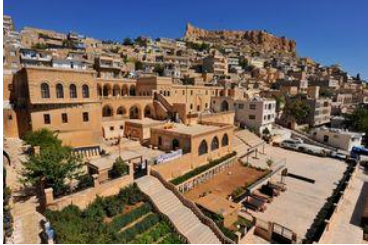
Şekil 17: Mardin Müze Binası
