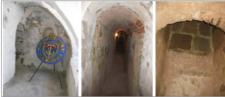
Şekil 16. Çanakkale Değirmenburnu Tabya Cephaneliği -soldan sağa- giriş bölümü, dehliz ve havalandırma bacası (Yeler, 2013)
