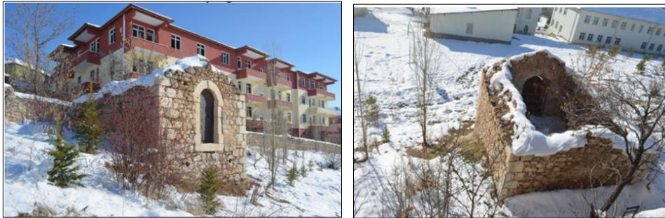
Şekil 28. Akdağmaden Cephanelik Binası (Topçu, 2014)
