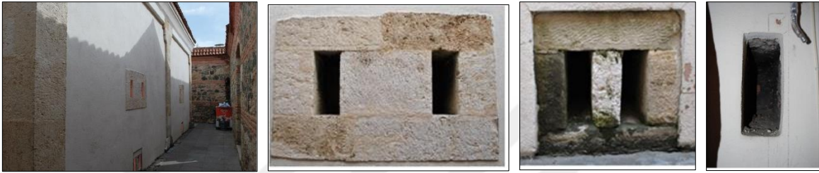
Şekil 51. Kastamonu Taşköprü Cephanelik Binası cephesinde havalandırma delikleri ve deliklerin iç mekândan görüntüsü (Aytekin, 2014)
