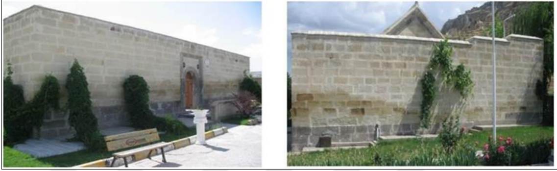
Şekil 32. Ürgüp Redif Birliği Cephanelik Binası (Özgen, 2013)
