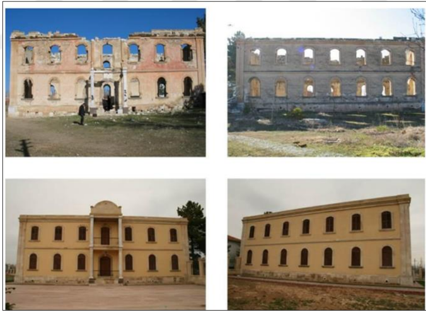
Şekil 26. Bolvadin Redif Deposu restorasyon öncesi ve sonrası (Özgen, 2013)
