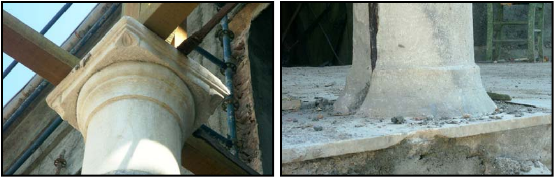
Resim 4.37. Muğla Hükümet Konağı kuzey cephesi – sütun başlığı ve alt bitiş
