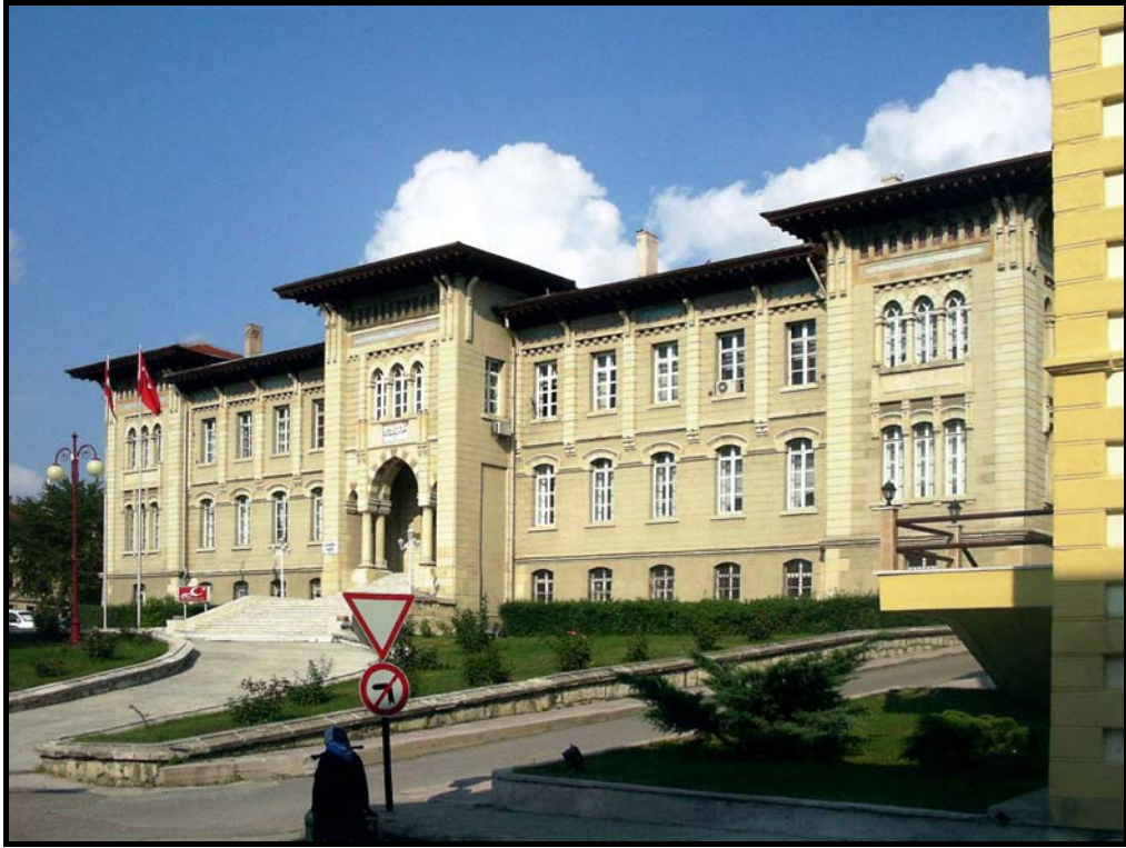
Resim 4.1. Kastamonu Hükümet Konağı
