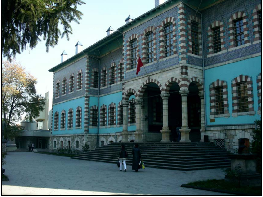
Resim 4.13. Kütahya Hükümet Konağı
