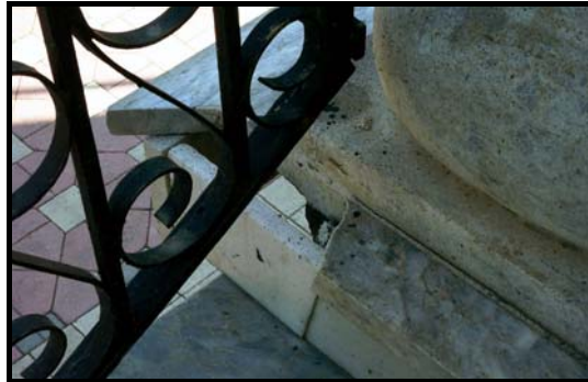
Resim 4.34. Sütun kaidesi-yeni kaplama malzemesi ilişkisi
