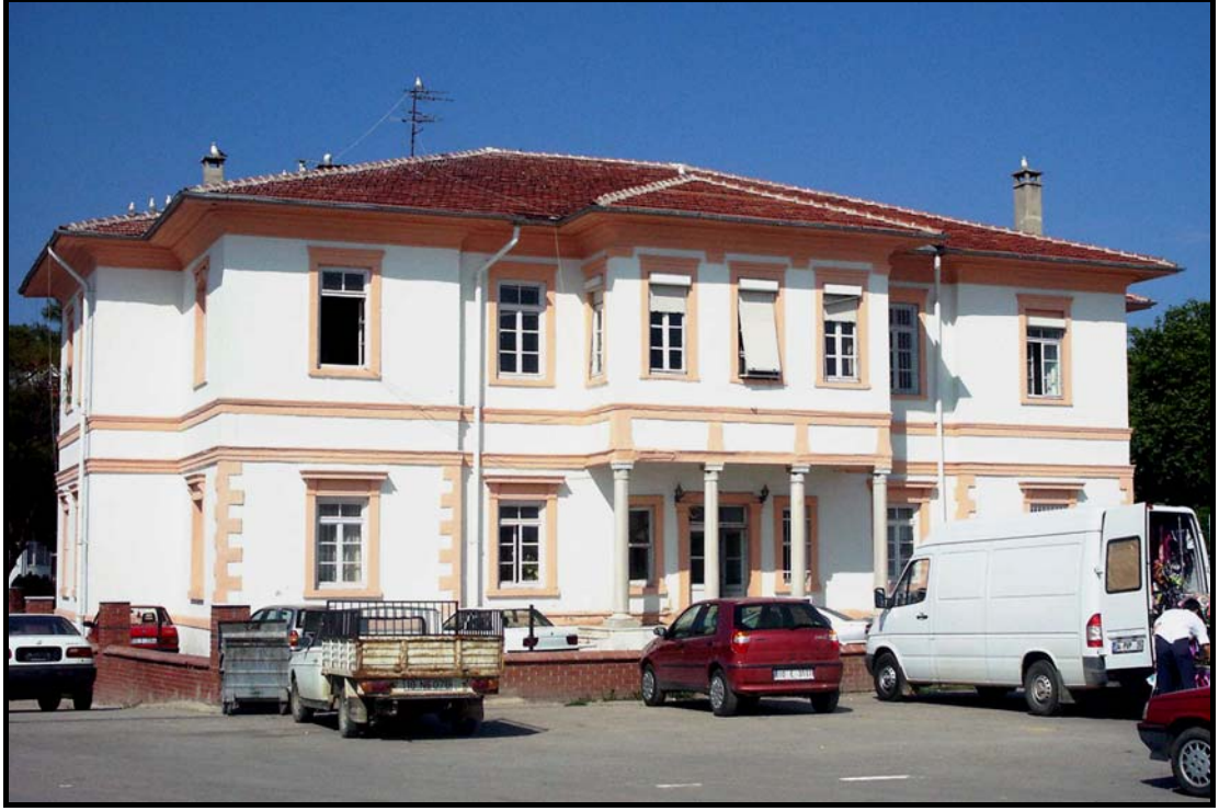
Resim 4.28. Erdek Hükümet Konağı
