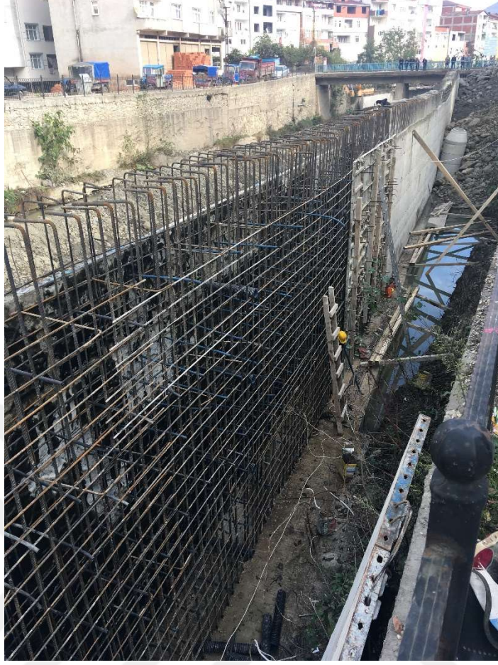
Şekil 8. Betonarme duvar örneği
