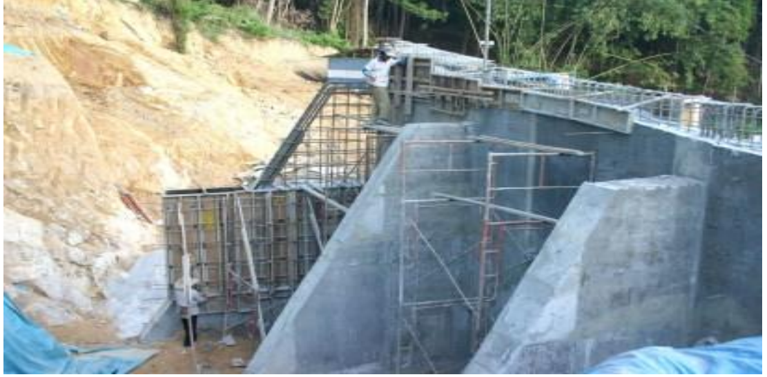
Şekil 1.14. Betonarme nervürlü istinat duvarı
