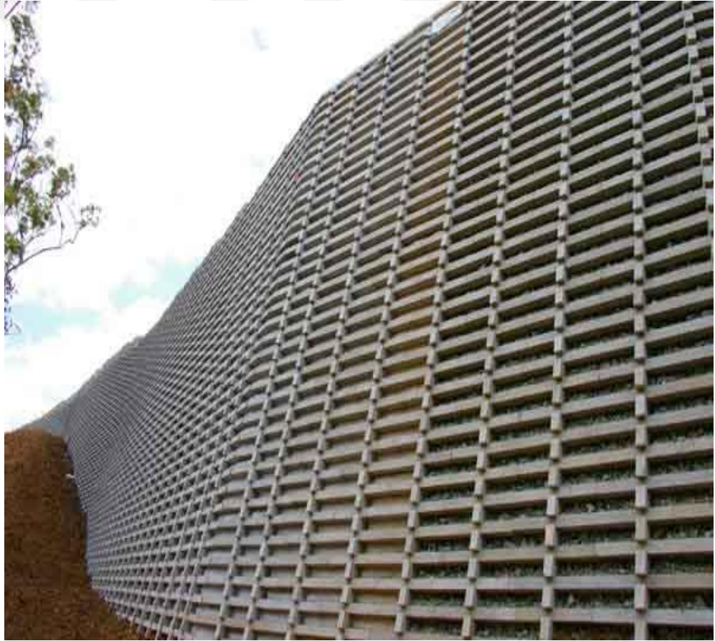
Şekil 1.11. Kafes tipi istinat duvarı
