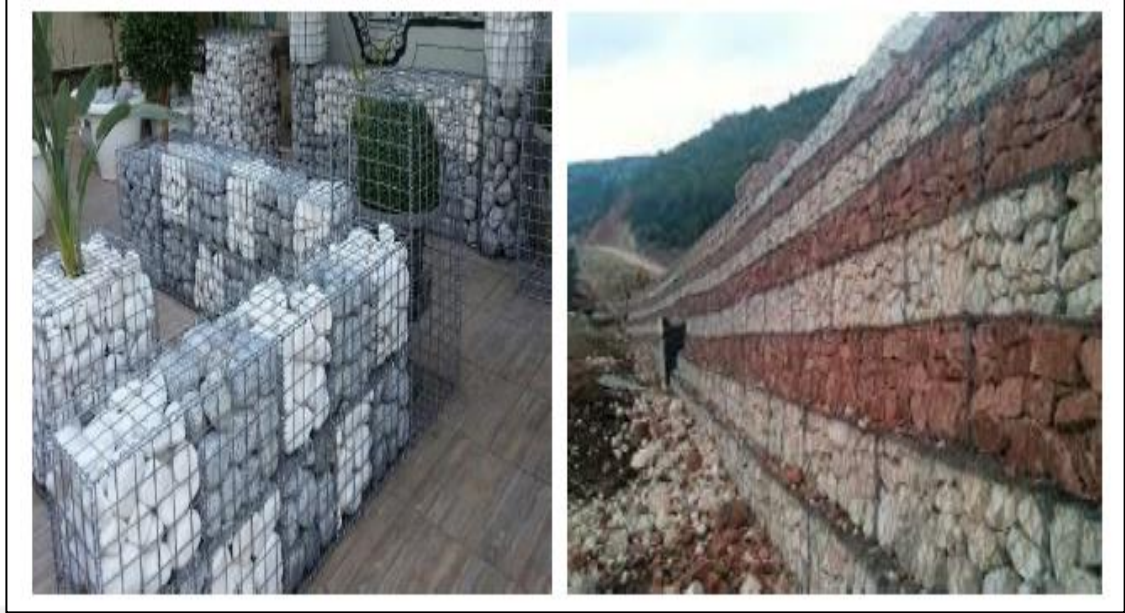
Şekil 1.12. Gabion duvar (Yıldırım 2019)
