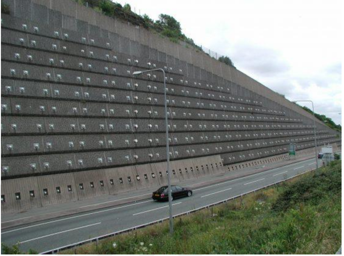
Şekil 1.15. Prefabrike istinat duvarı
