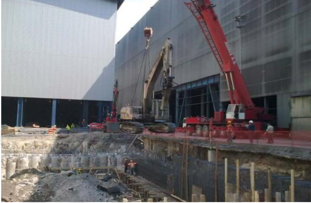
Şekil 3.5. İksa sistemi arkasında sürşarj yükü oluşturan ekipmanlar (Dayıoğlu 2010).
