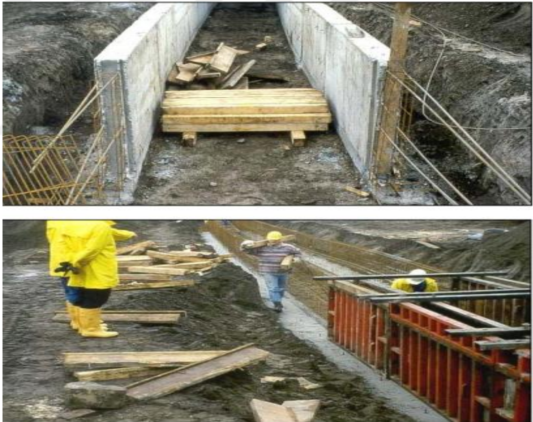
Şekil 4.2. Kılavuz Duvar (Natural Zemin 2016).
