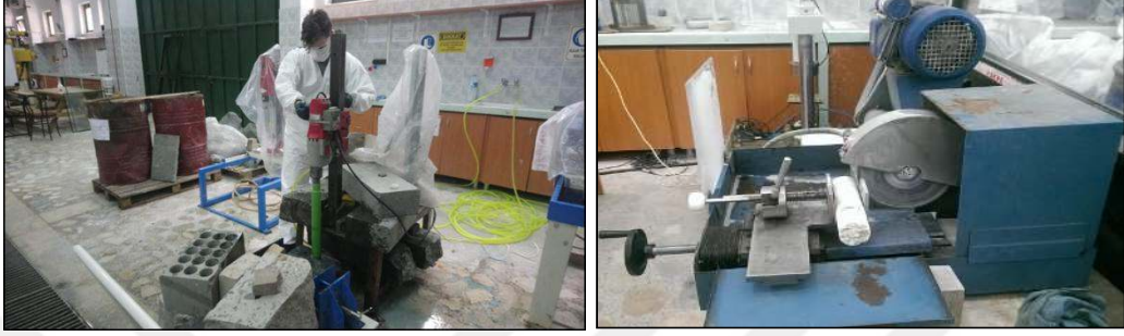
Şekil 2.2. Karot alma işlemi
