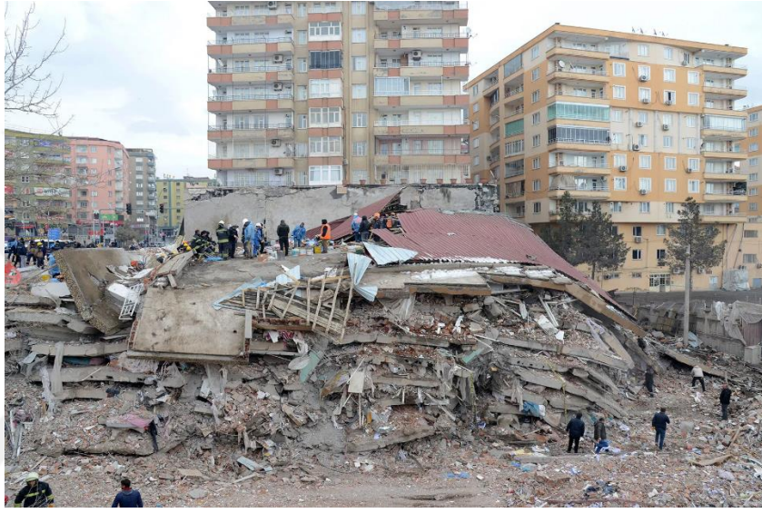
Görsel 2.2 6 Şubat 2023 Tarihinde Meydana Gelen Kahramanmaraş Depremlerinin Ardından Diyarbakır’da Yıkılan Bir Binada Arama Kurtarma Çalışmaları (Britannica, 2025)
