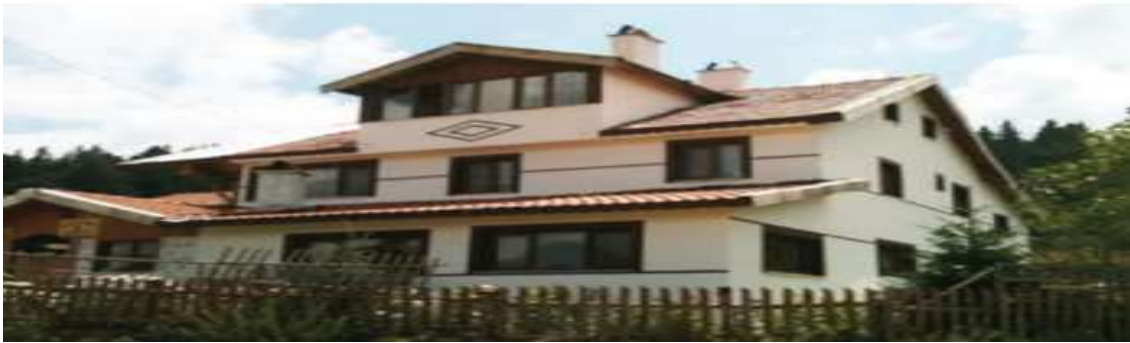
Şekil 19. Şehirden köye göç sonucu köyde yapılan yeni ev (Evirgen vd., 2019: 129)
