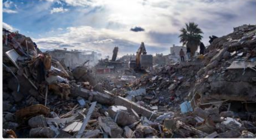
Görsel 7.3: Kahramanmaraş depreminin İskenderun'da yaptığı tahribat, Hatay
