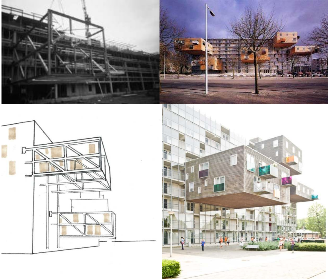
Şekil 4.28 Wozoco'daki eklenen birimlerin tasarım, montaj ve güncel görünümü
