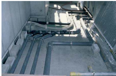
Şekil 4.35 Yatay sıhhi tesisat yerleşimi
