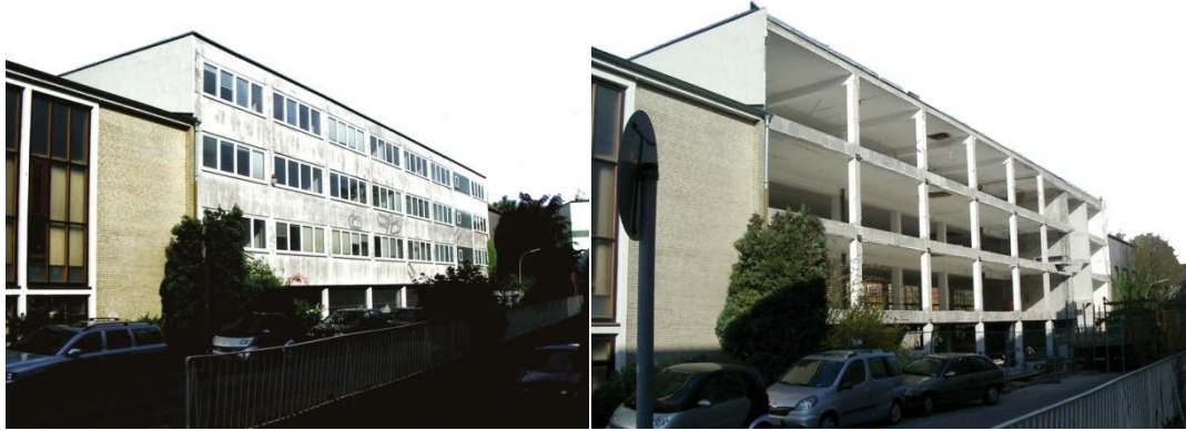
Şekil 4.70 İskelet Taşıyıcı Sistemin Sabit Tutulup, Cephelerin Ortadan Kaldırılması
