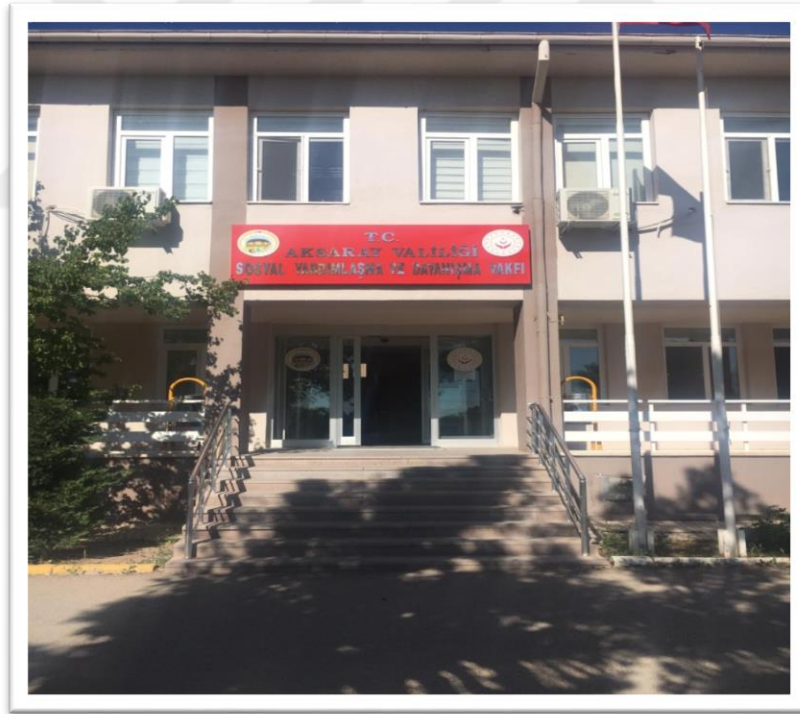
Şekil 9: Aksaray Sosyal Yardımlaşma ve Dayanışma Vakfı Hizmet Binası
