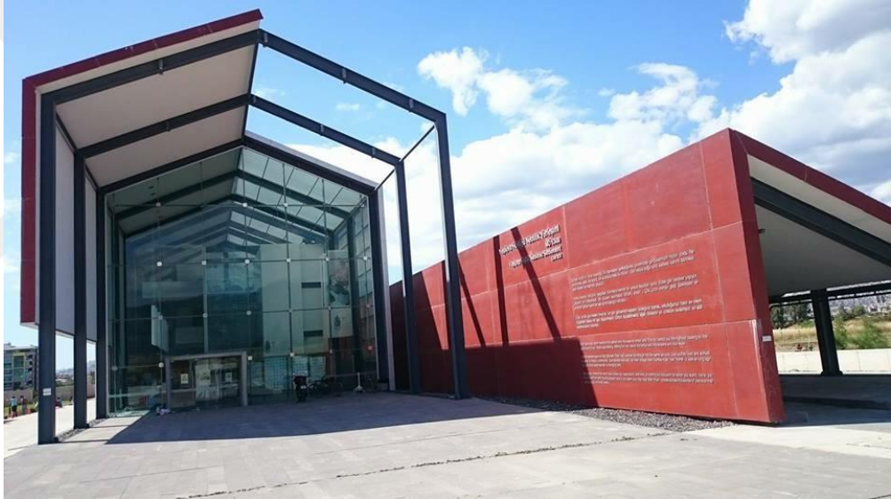
Şekil 27: Yeşilova Höyüğü Ziyaretçi Merkezi Binası
