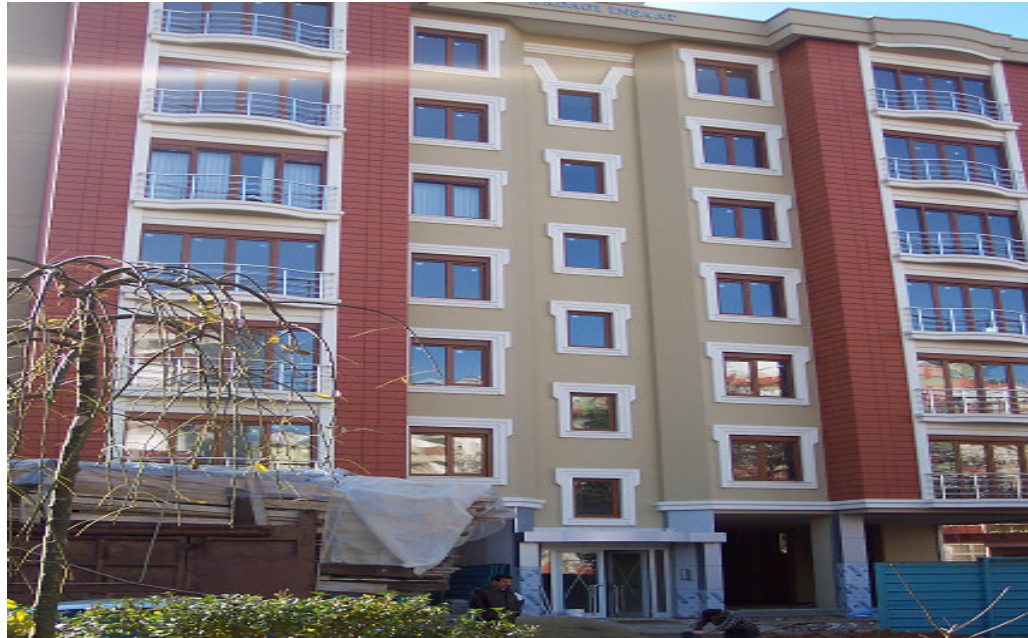
Resim 3.1. a- İstanbul İli, Kadıköy İlçesi örneği
