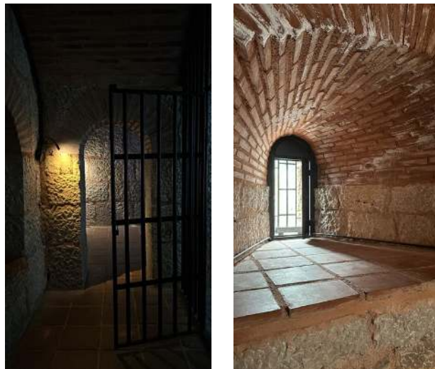
Şekil 6.17: Zindan Kapı restorasyon sonrası iç mekân.
