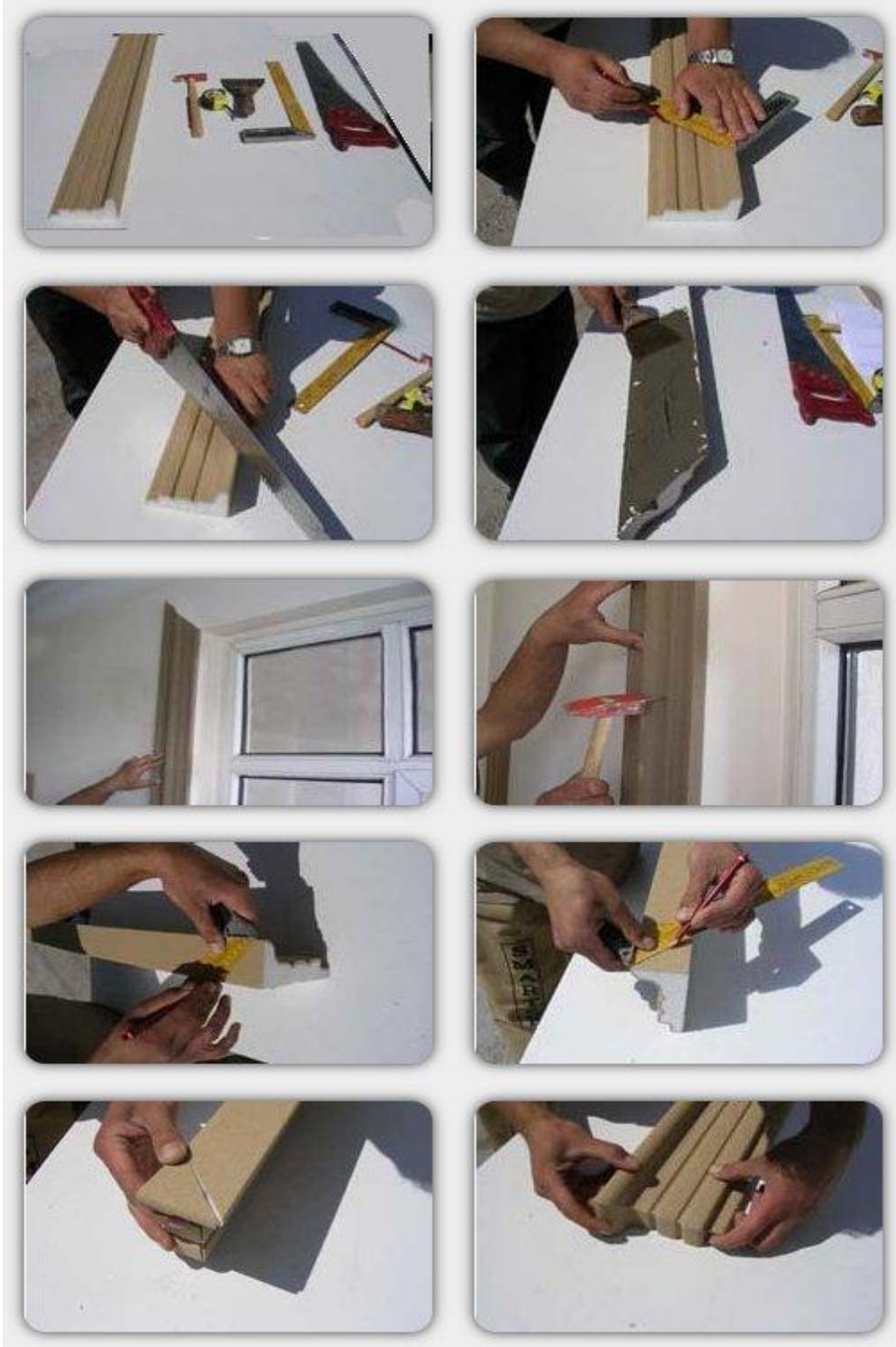
Resim 4.29. Söve Montaj veya Söve Uygulaması.
