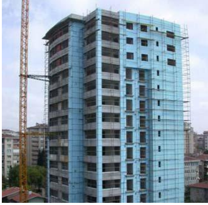
Resim 3.1. Dış Duvarlarda Dıştan Isı Yalıtımı Uygulaması.(Eps ve Xps)
