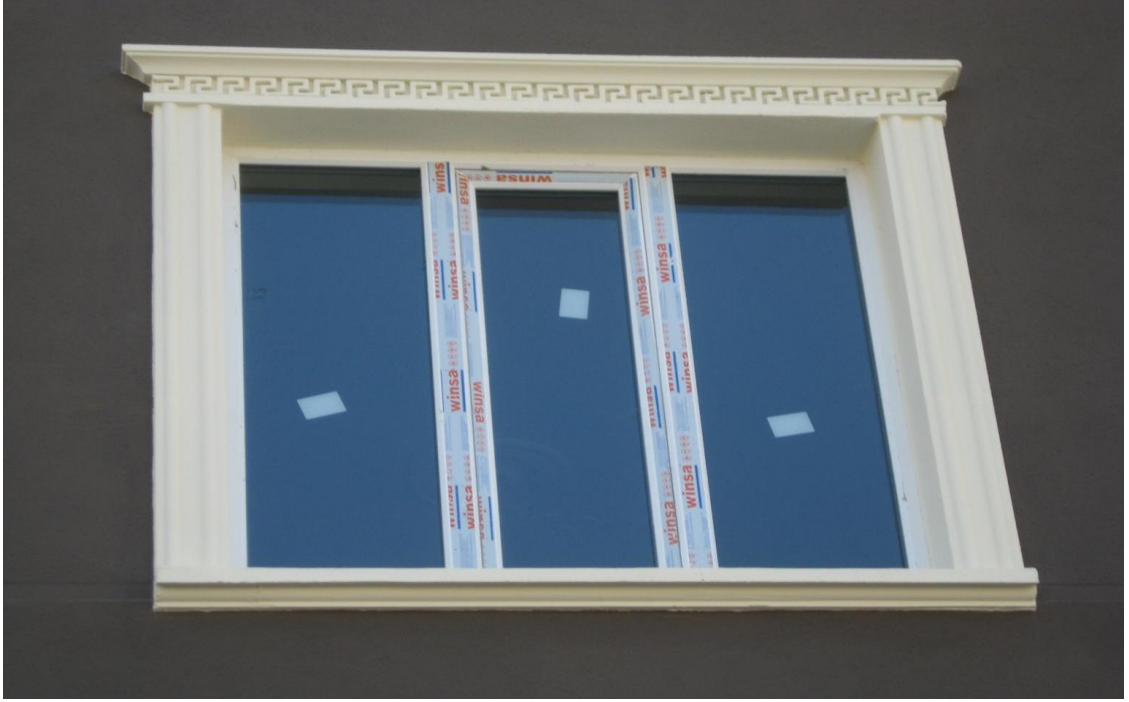
Resim 4.2. Söve Malzemesinin Pencereye Uygulanmış Şekli.
