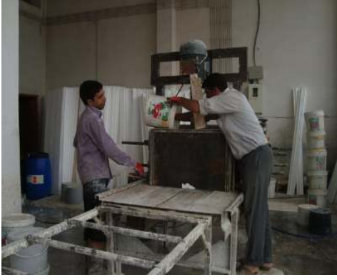
Resim 4.24. Söve Harcının, Harç Kaplama Kazanına Konulması [34].
