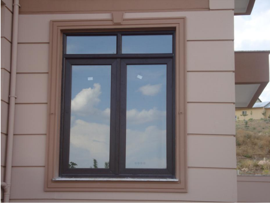
Resim 4.32. Söve ve kilit taşının pencereye uygulanmış hali (Hilalkent mahallesi/Elazığ).
