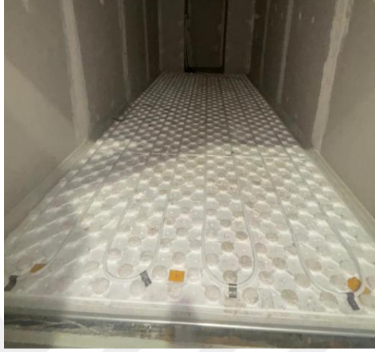
Şekil 4.9. Oxypex ve Alpex Isıtma Borusu
