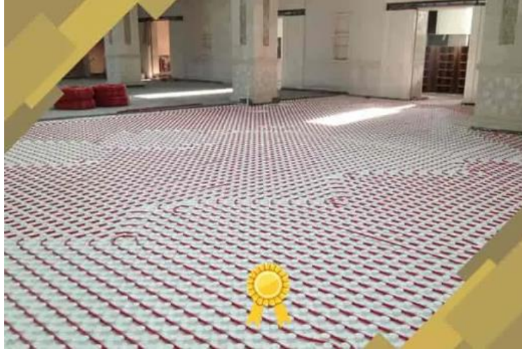
Şekil 3.3. Camilerde Yerden Isıtma Sistemi
