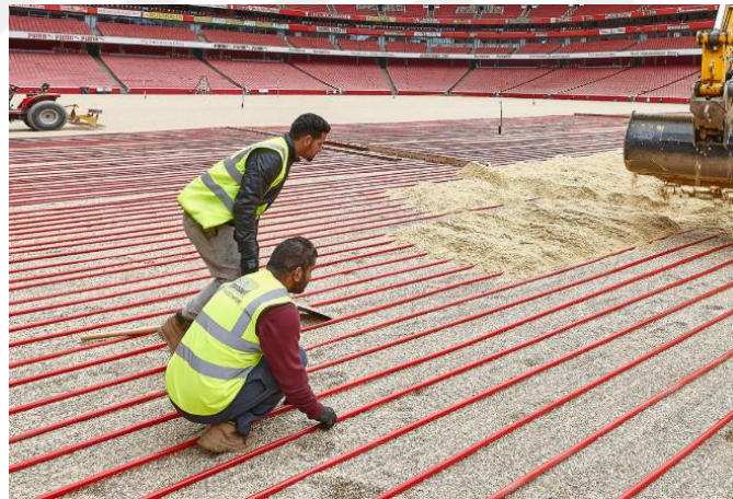
Şekil 3.4. Futbol Sahalarında Yerden Isıtma Sistemi
