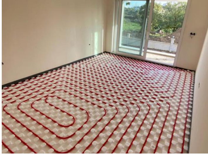
Şekil 3.1. Yerden Isıtma Sistemi
