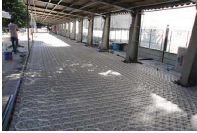
Şekil 3.7. Yüzme Havuzlarında Yerden Isıtma Sistemi
