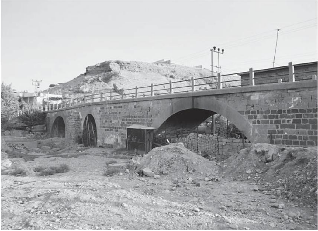
Foto 4. 17. Deşt Köprüsü'nün Mansap Cephesi
