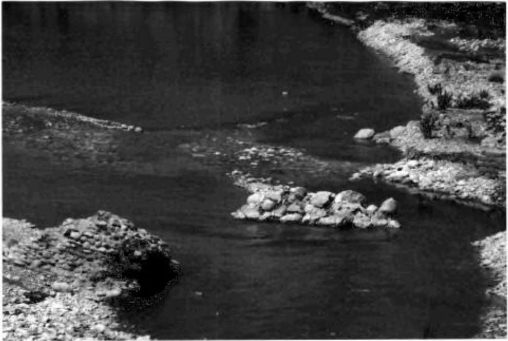
Foto 4. 37. Bürücek Köprüsü'nün Sırasıyla Kuzeybatı ve Güneydoğu Görünüşü
