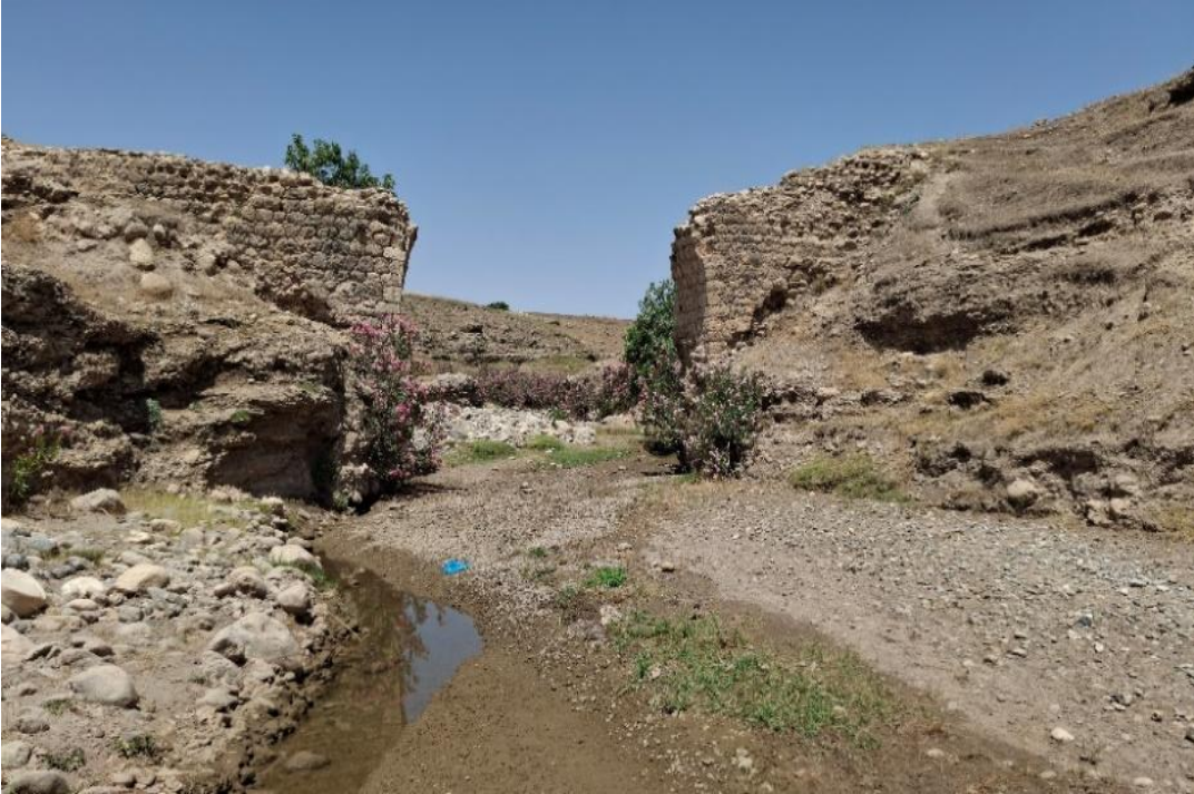
Foto 4. 46. Cem'a Birlik Köprüsü'nün Doğu Görünüşü
