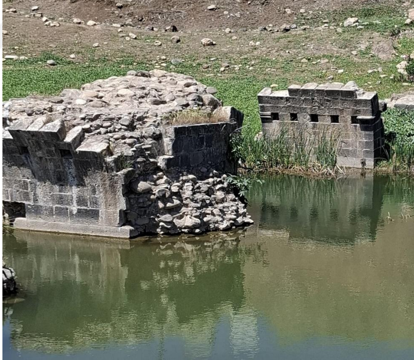
Foto 4. 28. Saklan (Ciddeyt) Köprüsü'nün Ayaklarının Güneybatı Görünüşü
