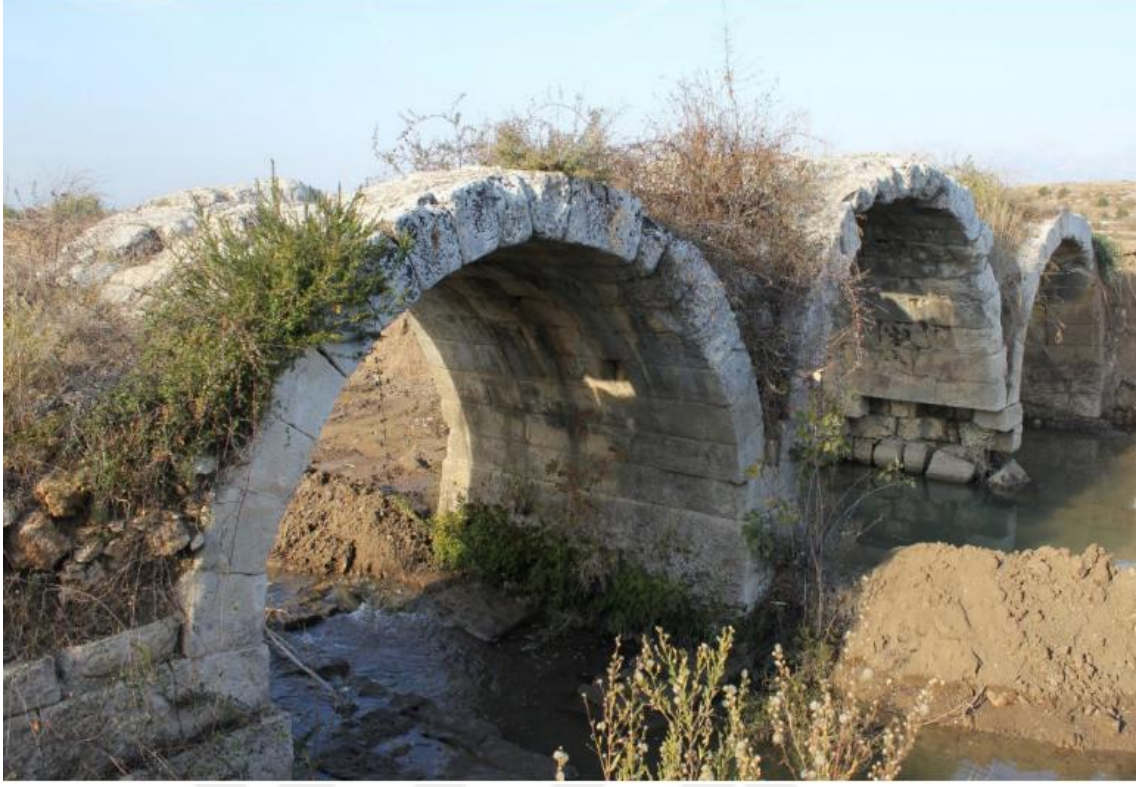
Foto 3.5. Antalya - Sillyon Roma Dönemi Köprüsü'nün (Ayvalıkemer) Restorasyon Öncesi Görünümü
