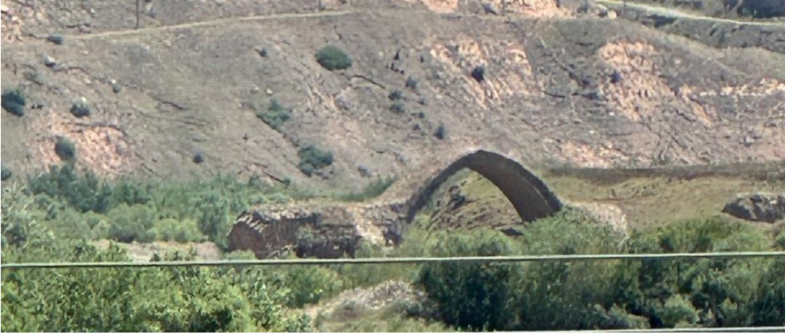
Foto 4. 12. Yafes Köprüsü'nün Batı Görünüşü
