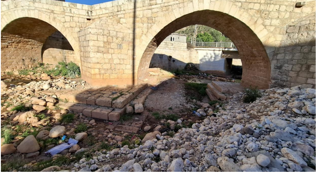
Foto 4. 8. Kasrik Köprüsü'nün Kuzeybatı Görünüşü
