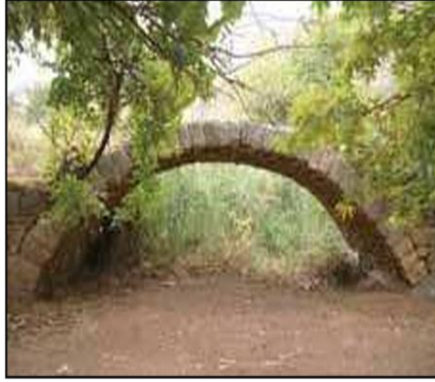
Foto 4. 42. Pavan Köprüsü'nün Genel Görünümü
