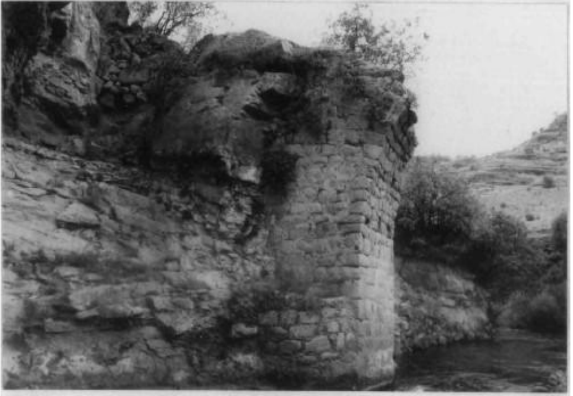
Foto 4. 41. Pavan Köprüsünün Ayakları
