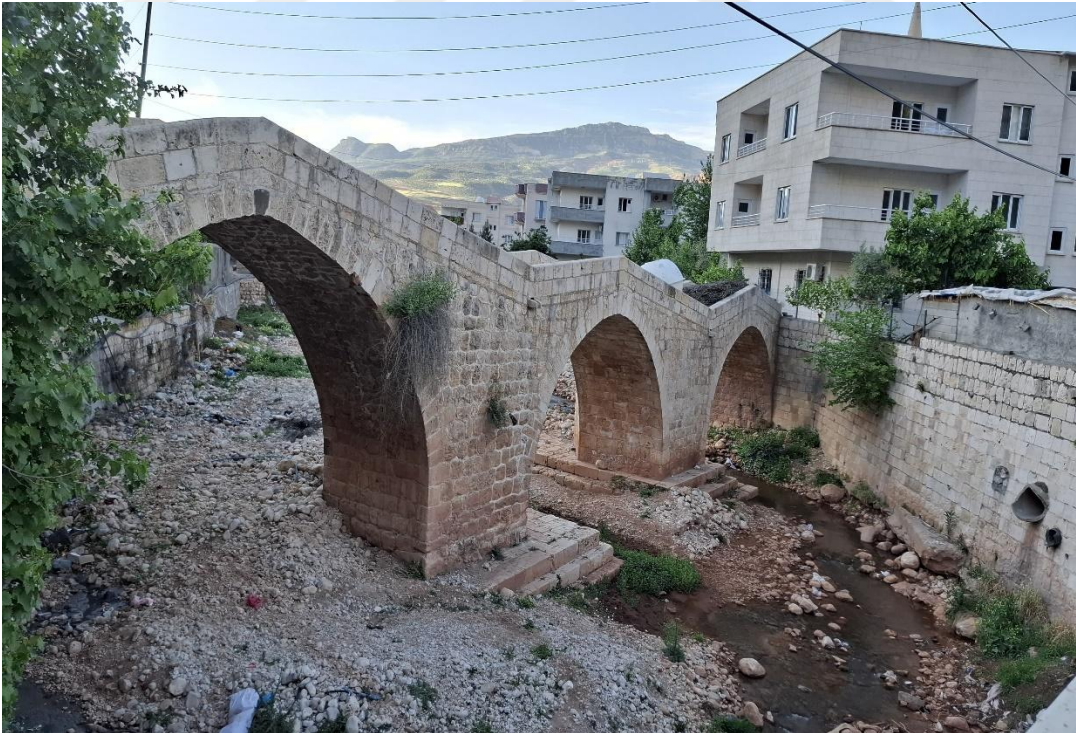
Foto 4. 5. Restorasyon Sonrası Kasik Köprüsü'nün Kuzeydoğu Görünüşü
