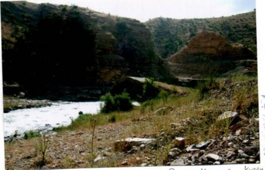
Foto 4. 64. Beyaz Köprü'nün Kuzey Görünüşü
