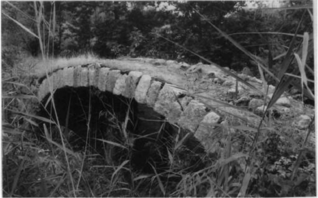
Foto 4. 40. Pavan Köprüsünün Kemer Detayı
