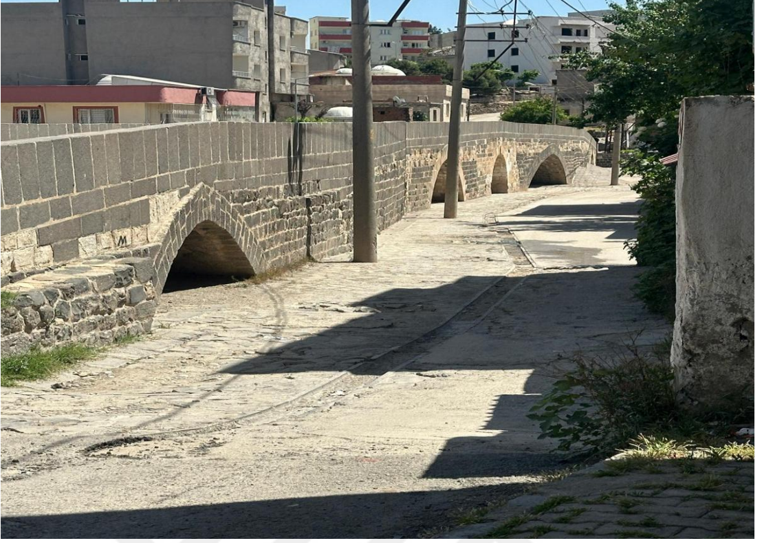
Foto 4. 19. Değirli Köprüsü'nün Batı Görünüşü
