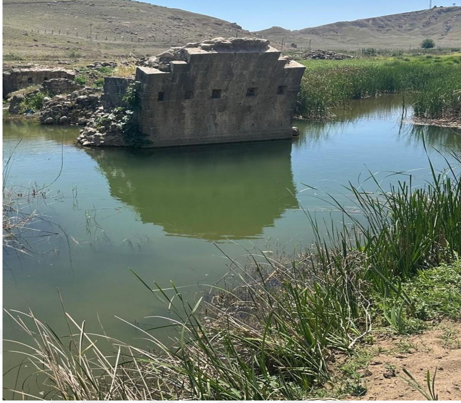
Foto 4. 27. Saklan (Ciddeyt) Köprüsü'nün Ayak Kalıntısı'nın Güneydoğu Görünüşü
