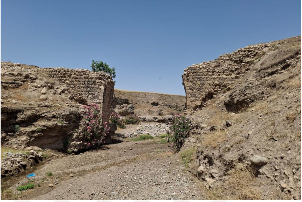
Foto 4. 47. Cem'a Birlik Köprüsü'nün Kuzeydoğu Görünüşü
