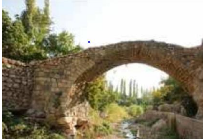
Foto 4. 53. Restorasyon Öncesi Görümlü Köprüsü
