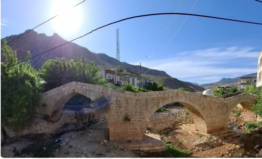
Foto 4. 6. Kasrik Köprüsü'nün Kuzey Görünüşü
