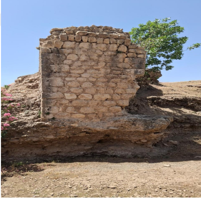
Foto 4. 48. Cem'a Birlik Köprüsü'nün Güney Ayağının Görünüşü
