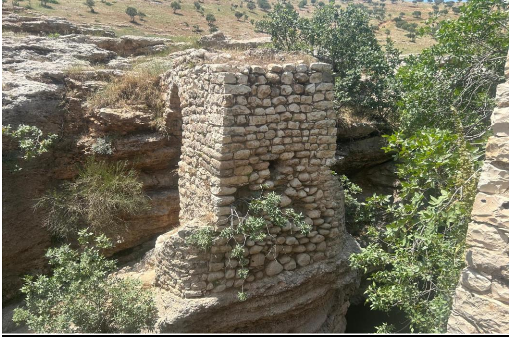
Foto 4. 71. Hisar Köprüsünün Güneydoğu Yönünden Orta Ayak Görünüşü
