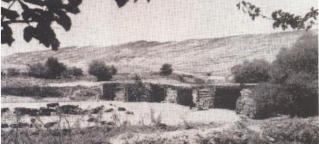
Foto 3.10. Ankara - Iuliopolis Sarılar Köprüsü
