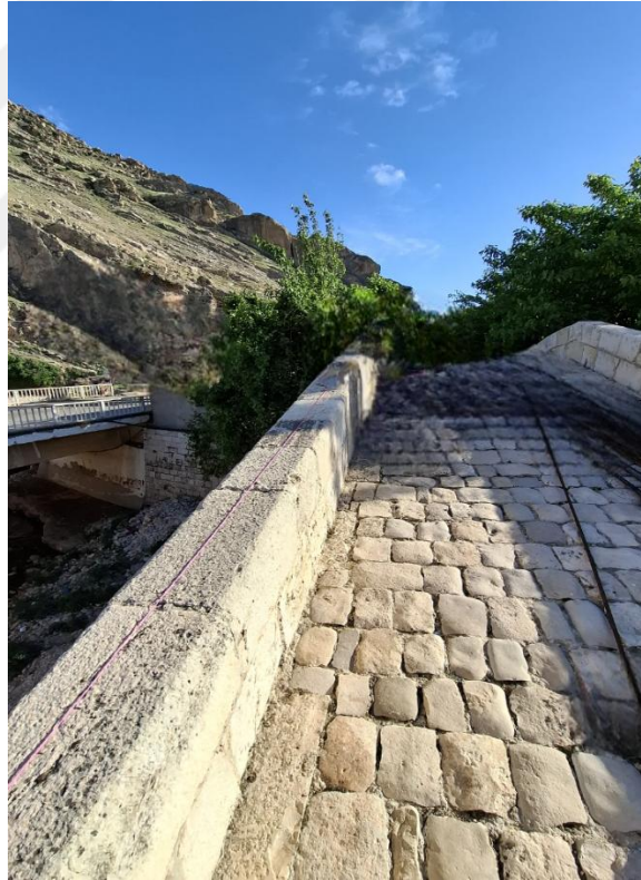
Foto 4. 9. Kasrik Köprüsü'nün Üstten Görünüşü
