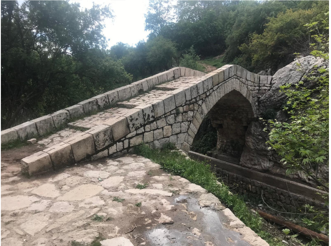
Foto 4. 54. Görümlü Köprüsü'nün Güneydoğu Görünüşü
