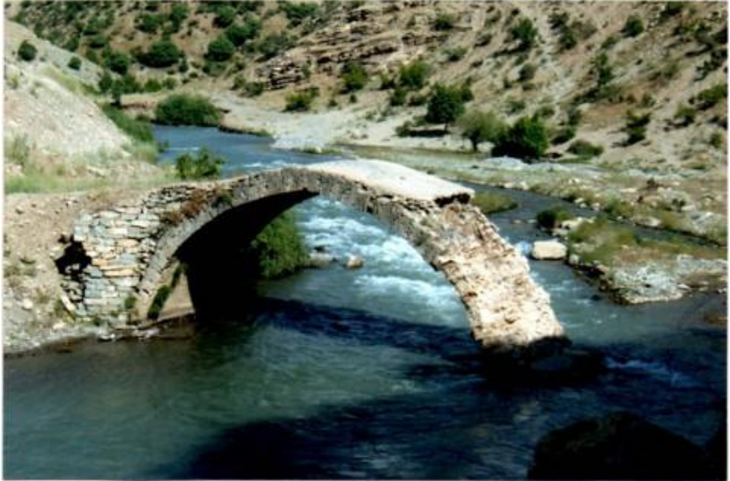
Foto 4. 60. Beyaz Köprü'nün Kuzeydoğu Görünüşü
