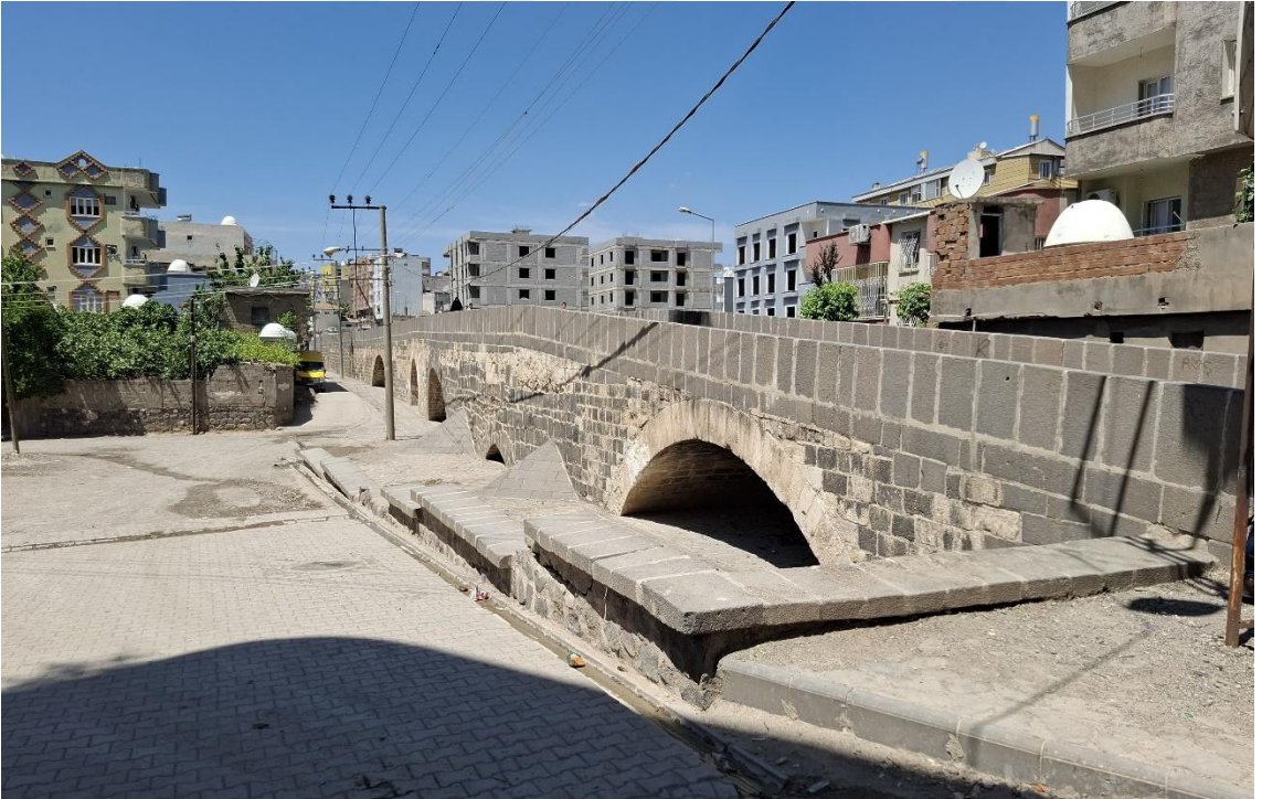
Foto 4. 22. Deşt Köprüsü'nün Güney Görünüşü
