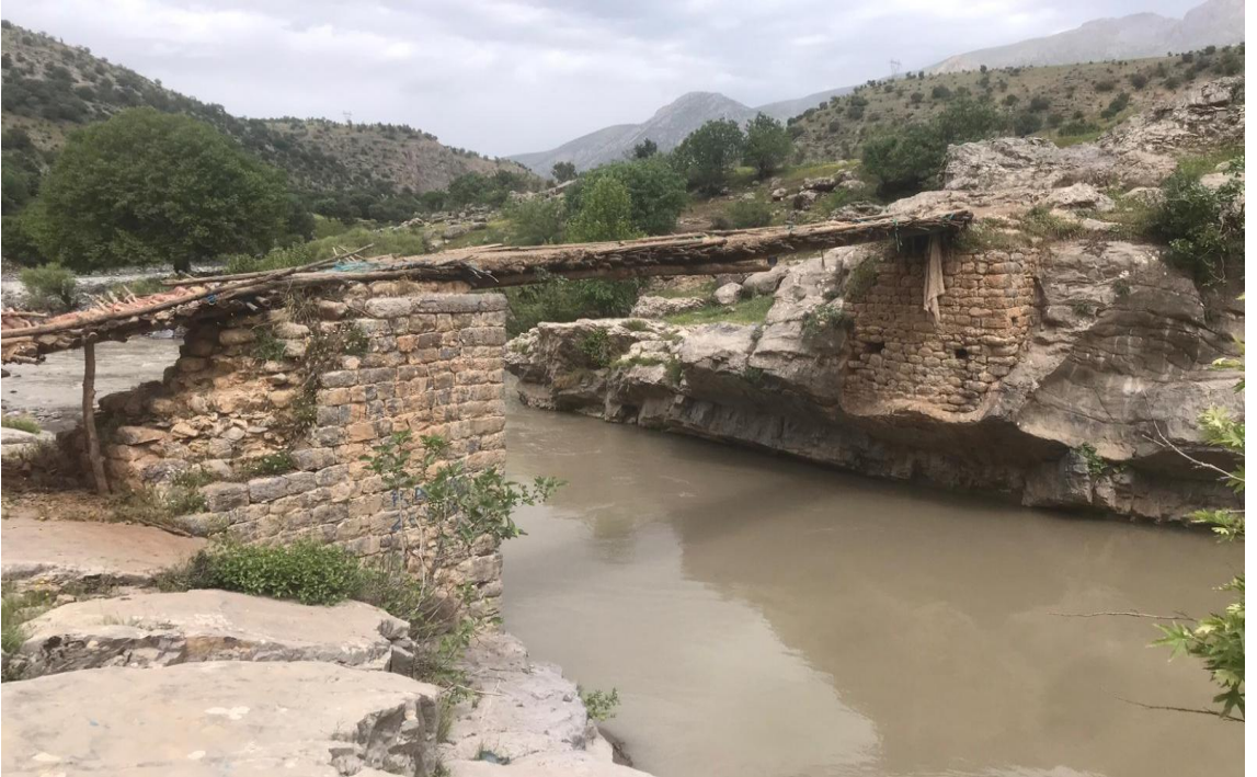
Foto 4. 67. Şenoba Köprü'sünün Güneybatı Görünüşü
