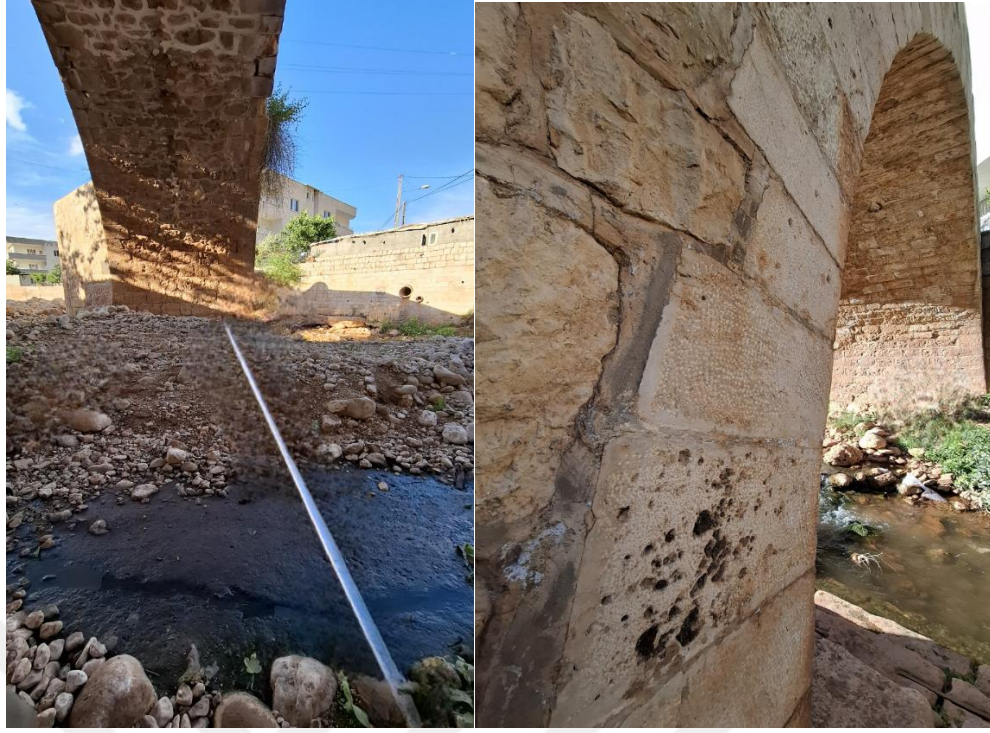
Foto 4. 10. Kasrik Köprüsü'nün Ayaklarının Görünüşü
