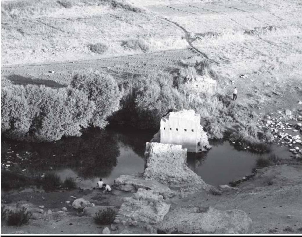
Foto 4. 25. Saklan Köprüsü'nün Genel Görünüşü
