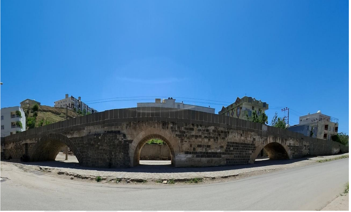
Foto 4. 21. Deşt Köprüsü'nün Güneybatı Görünüşü
