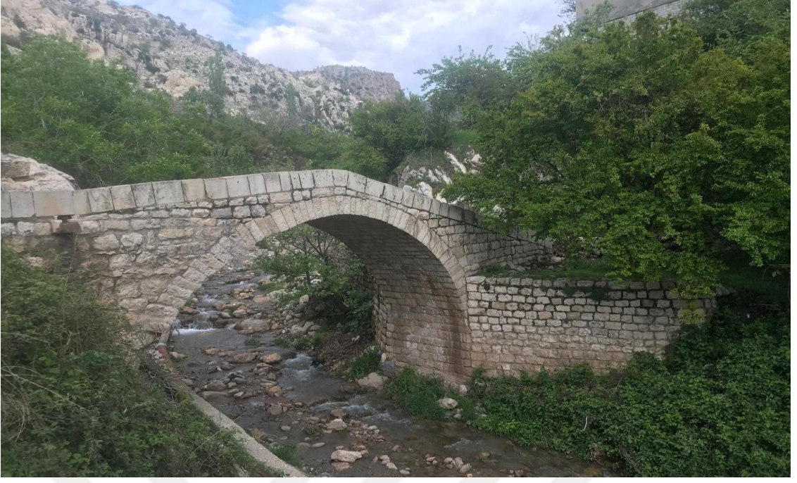
Foto 4. 55. Görümlü Köprüsü'nün Güney Görünüşü
