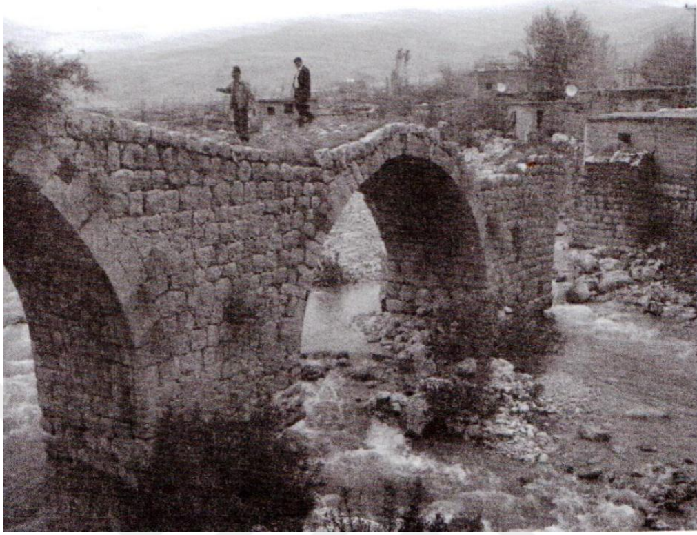
Foto 4. 1. Kasrik (Han Mahmut / Mahmuthan Bey) Köprüsü Mansap Görünüşü
