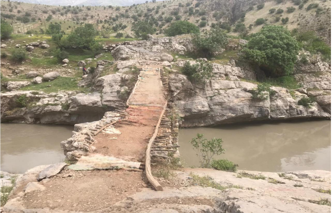
Foto 4. 69. Şenoba Köprü'sünün Üstten Görünüşü
