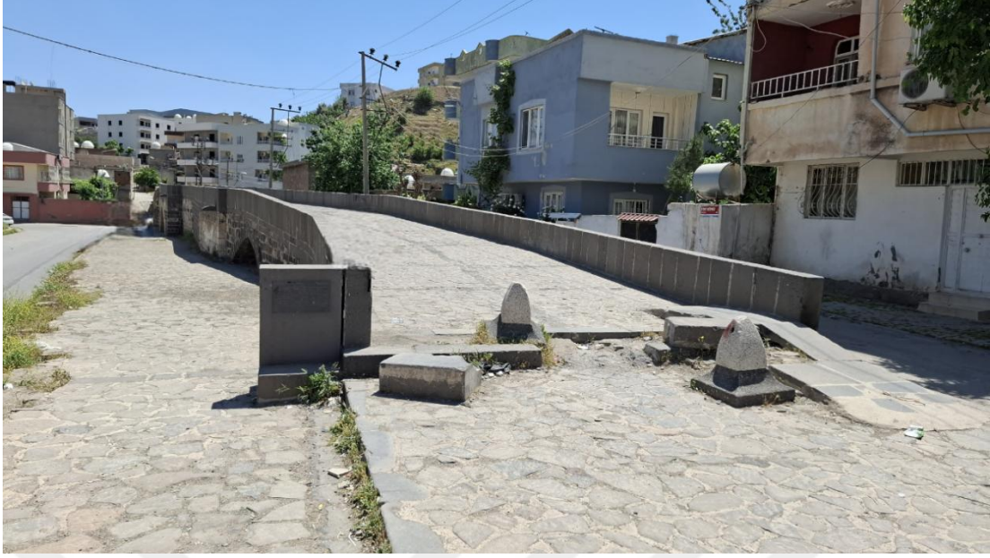
Foto 4. 23. Deşt Köprüsü'nün Üstten Görünüşü
