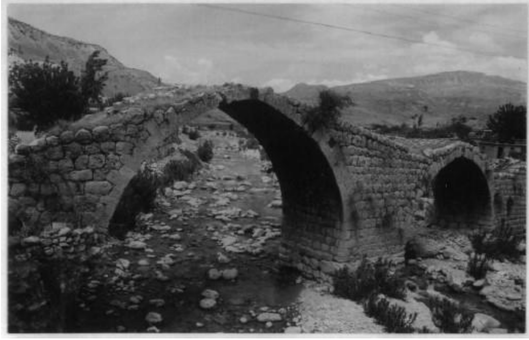
Foto 4. 4. Kasik (Han Mahmut / Mahmuthan Bey) Köprüsü'nün Restorasyon Öncesi Kuzeydoğu Görünüşü
