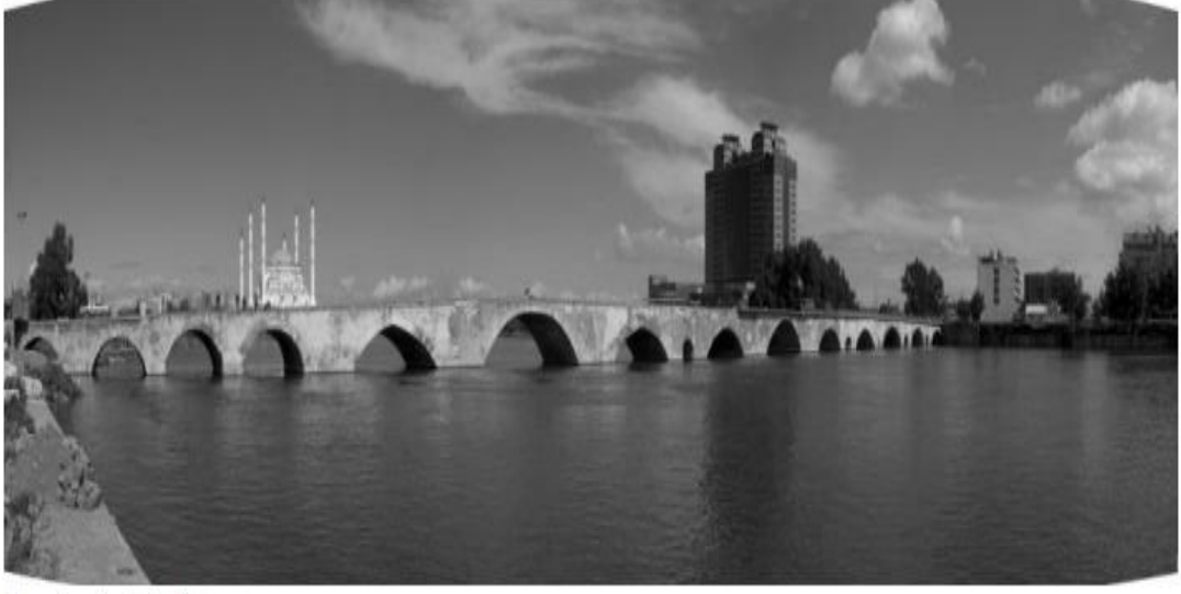
Foto 3.4. Adana'da Roma Dönemi Köprüsü: Taş Köprü
