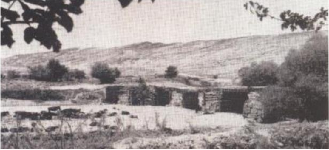
Foto 3.10. Ankara - Iuliopolis Sarılar Köprüsü
