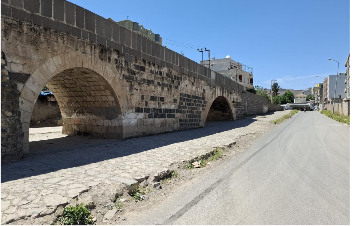
Foto 4. 20. Deşt Köprüsü'nün Kemer Görünüşü
