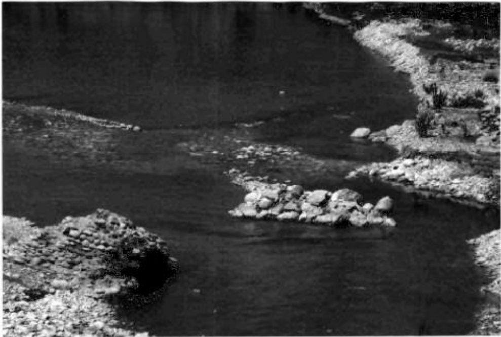
Foto 4. 37. Bürücek Köprüsü'nün Sırasıyla Kuzeybatı ve Güneydoğu Görünüşü
