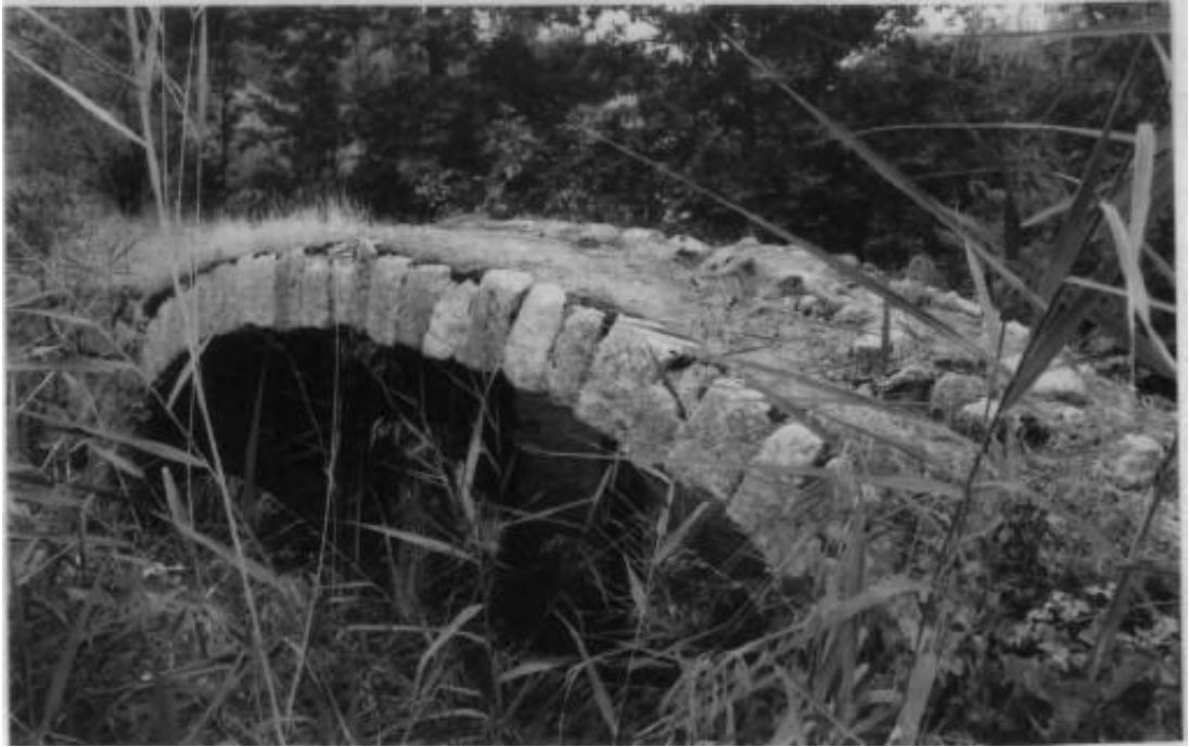
Foto 4. 40. Pavan Köprüsünün Kemer Detayı
