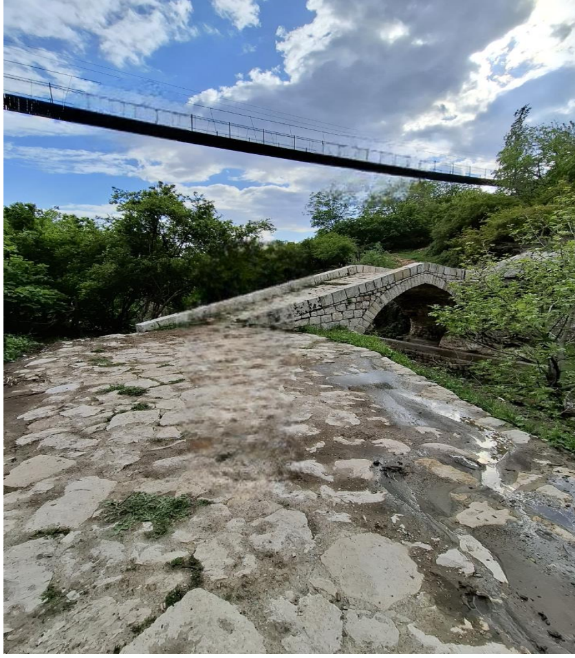
Foto 4. 57. Görümlü Köprüsü'nün Genel Görünümü
