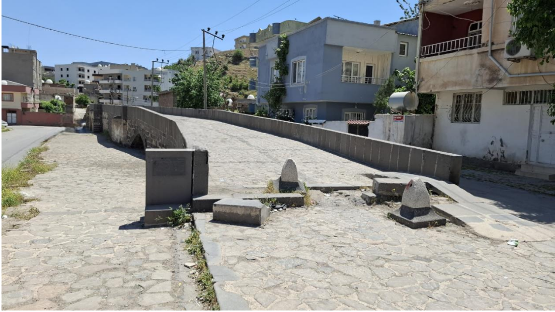
Foto 4. 23. Deşt Köprüsü'nün Üstten Görünüşü
