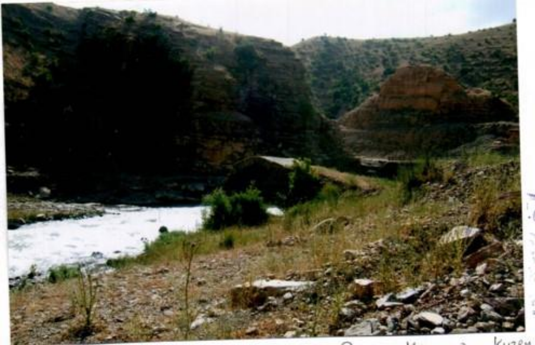
Foto 4. 64. Beyaz Köprü'nün Kuzey Görünüşü
