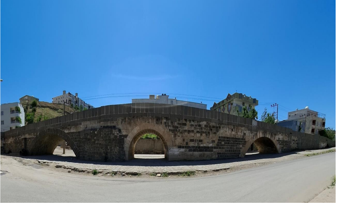
Foto 4. 21. Deşt Köprüsü'nün Güneybatı Görünüşü
