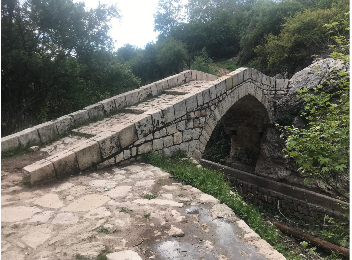
Foto 4. 54. Görümlü Köprüsü'nün Güneydoğu Görünüşü
