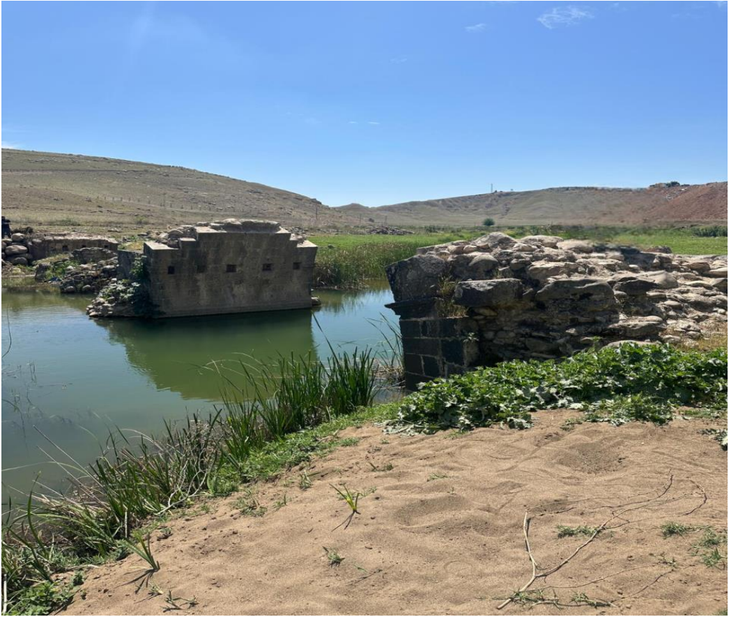
Foto 4. 30. Saklan (Ciddeyt) Köprüsü'nün Güneydoğu Görünüşü
