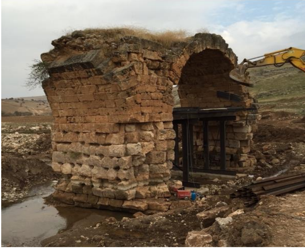
Foto 3.7. Gaziantep – Araban / Karasu Köprüsü
