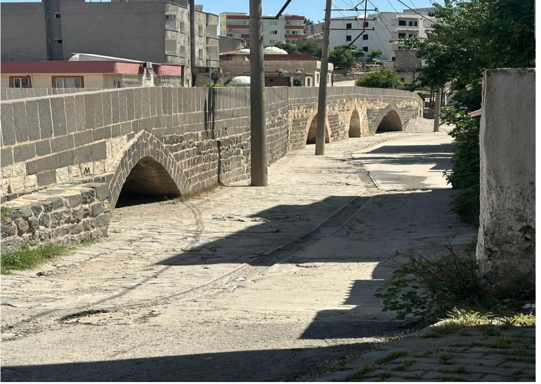
Foto 4. 19. Deşt Köprüsü'nün Batı Görünüşü
