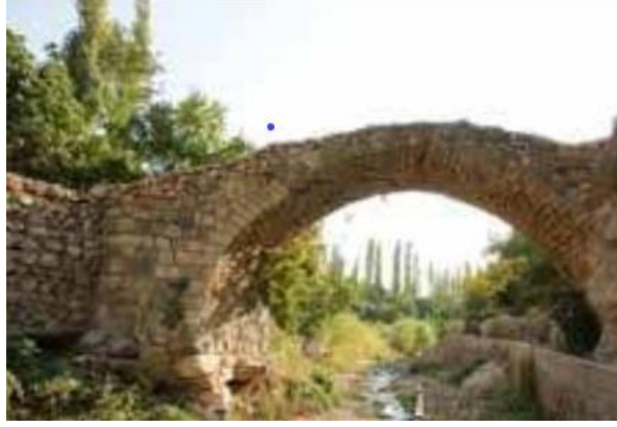
Foto 4. 53. Restorasyon Öncesi Görümlü Köprüsü
