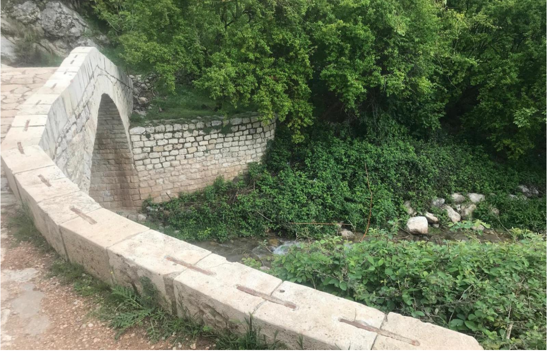
Foto 4. 56. Görümlü Köprüsü'nün Üstten Görünümü
