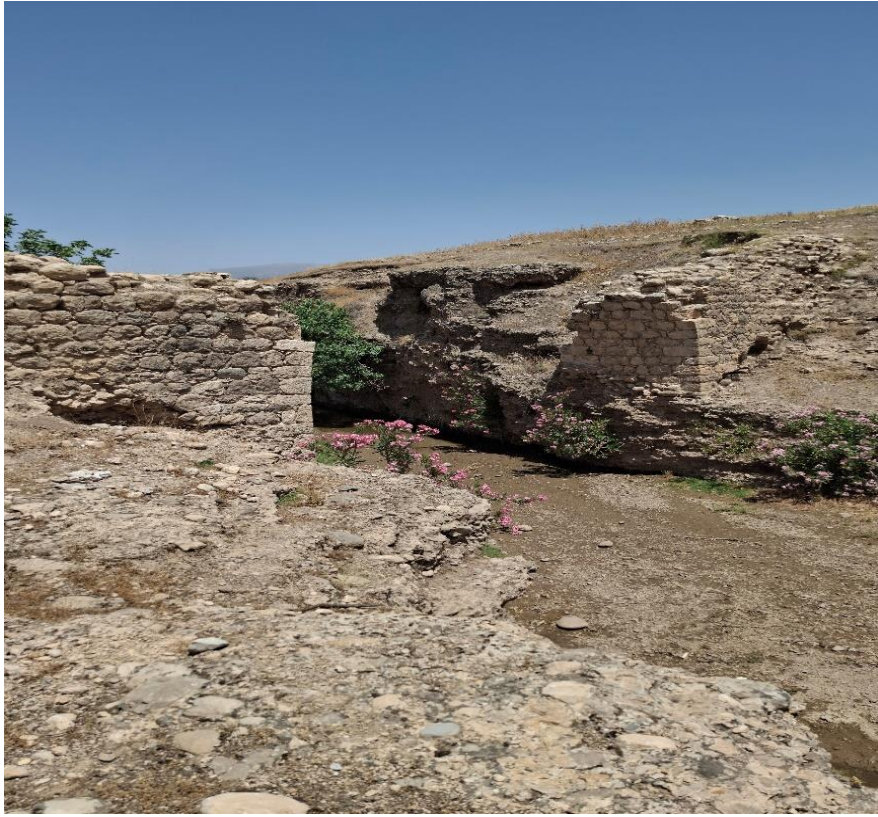
Foto 4. 44. Cem'a (Birlik) Köyü Taş Köprüsü'nün Mevcut Kalıntısı
