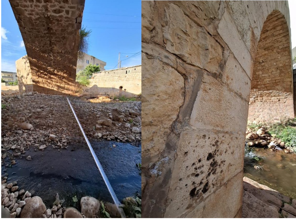
Foto 4. 10. Kasrik Köprüsü'nün Ayaklarının Görünüşü
