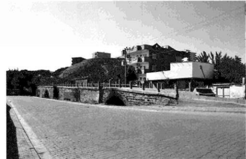
Şırnak İl, Cizre İlçesi, Akabin-Deşt Köprüsü, 2011 Yılı Kazısı.
