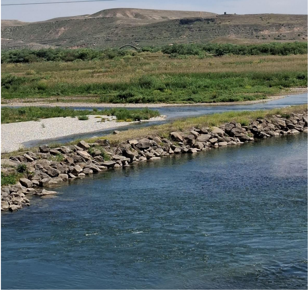
Foto 4. 14. Yafes Köprüsü'nün Güney Görünüşü
