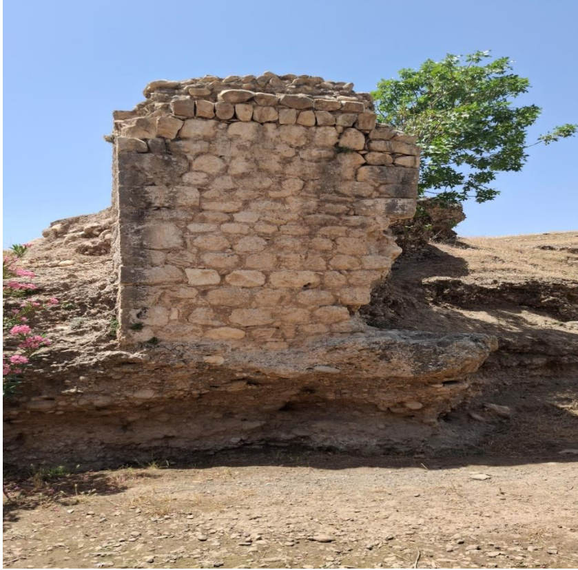
Foto 4. 48. Cem'a Birlik Köprüsü'nün Güney Ayağının Görünüşü
