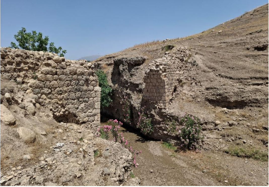
Foto 4. 45. Cem'a Birlik Köprüsü'nün Güneydoğu Görünüşü
