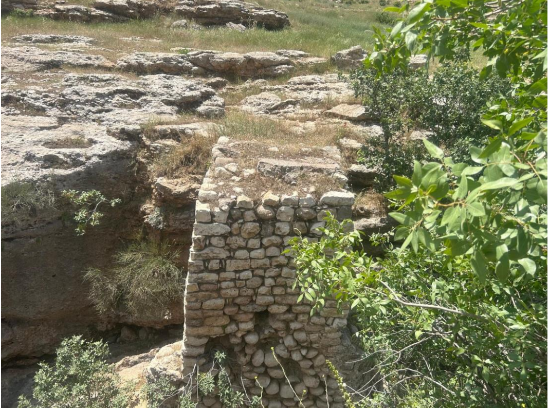
Foto 4. 72. Hisar Köprüsü'nün Orta Ayak İtibariyle Üstten Görünüşü
