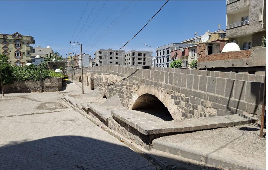
Foto 4. 22. Deşt Köprüsü'nün Güney Görünüşü
