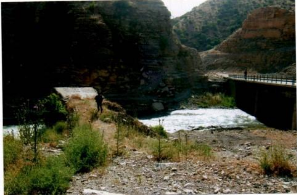
Foto 4. 62. Beyaz Köprü'nün Üstten Görünüşü
