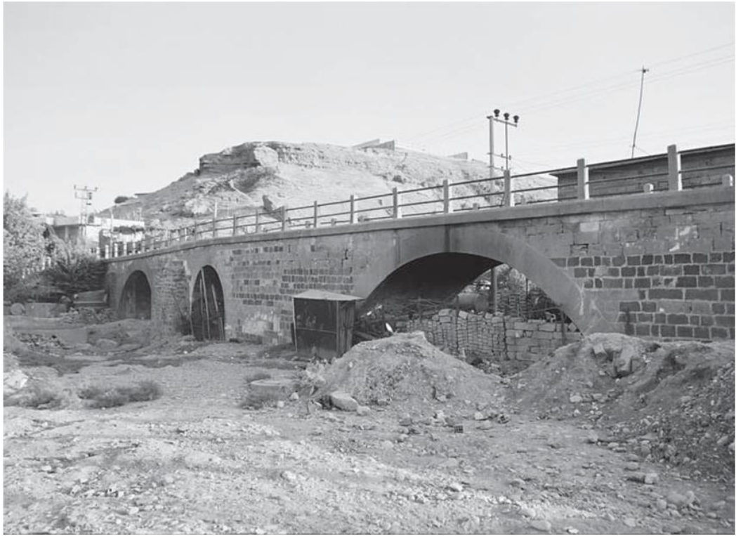
Foto 4. 17. Deşt Köprüsü'nün Mansap Cephesi
