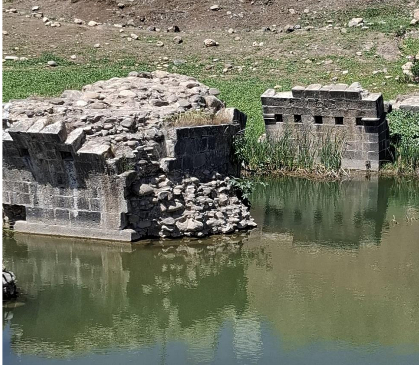
Foto 4. 28. Saklan (Ciddeyt) Köprüsü'nün Ayaklarının Güneybatı Görünüşü
