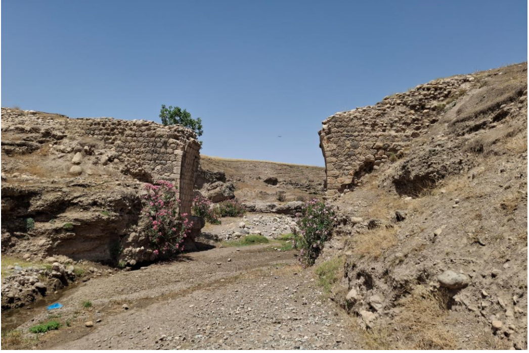
Foto 4. 47. Cem'a Birlik Köprüsü'nün Kuzeydoğu Görünüşü
