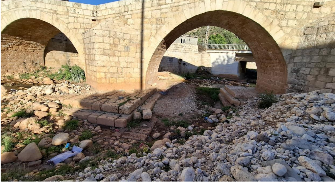
Foto 4. 8. Kasrik Köprüsü'nün Kuzeybatı Görünüşü
