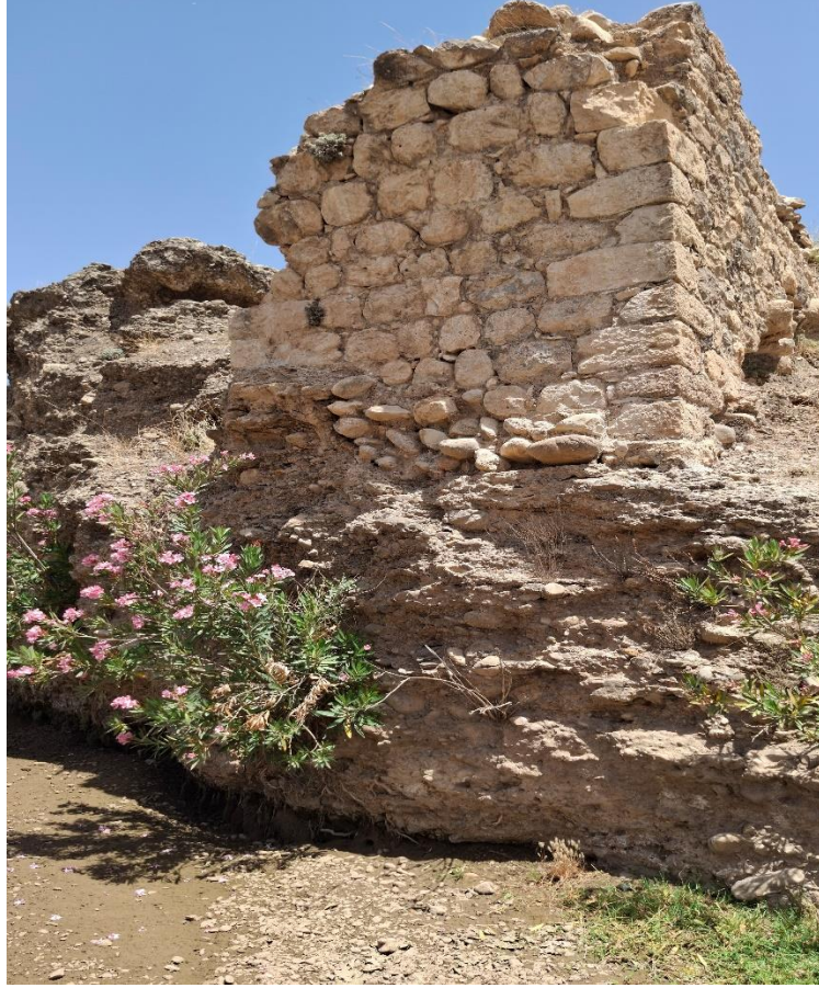
Foto 4. 49. Cem'a Birlik Köprüsü'nün Kuzey Ayağının Görünüşü
