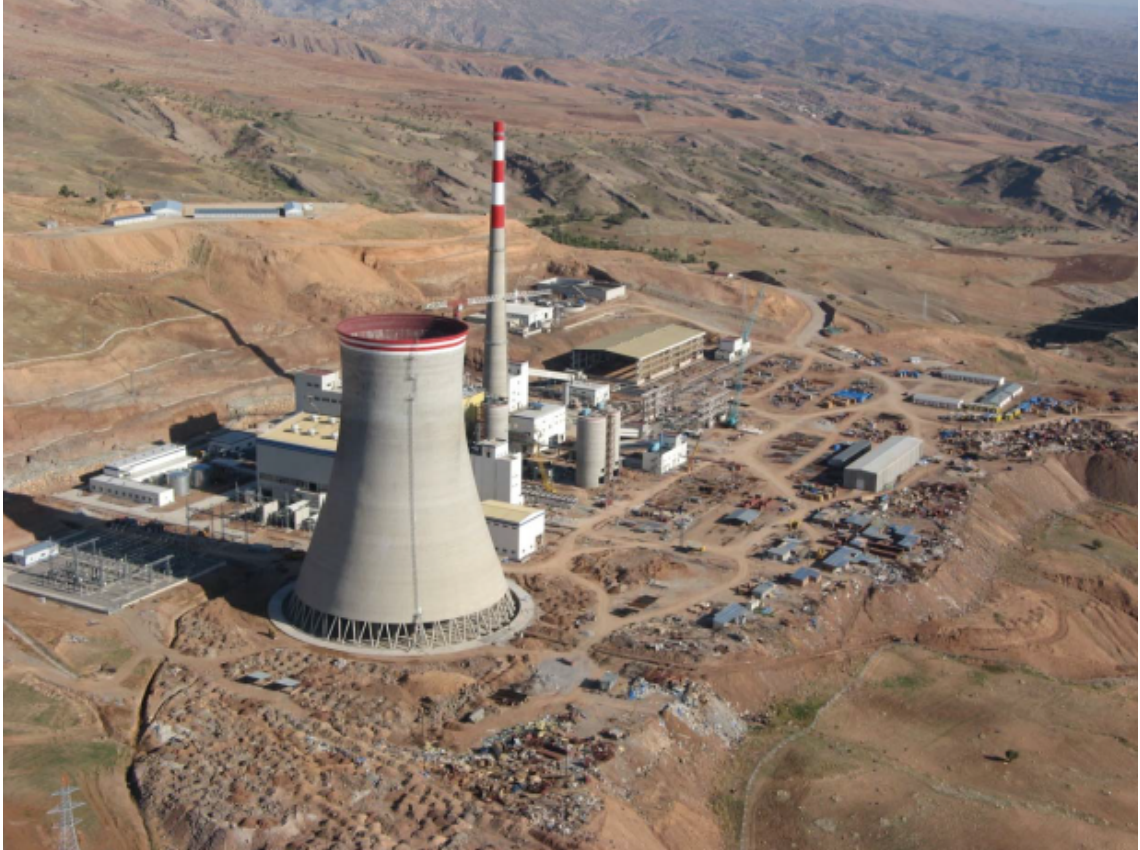
Şekil 4.38. Silopi termik santral görüntüsü
