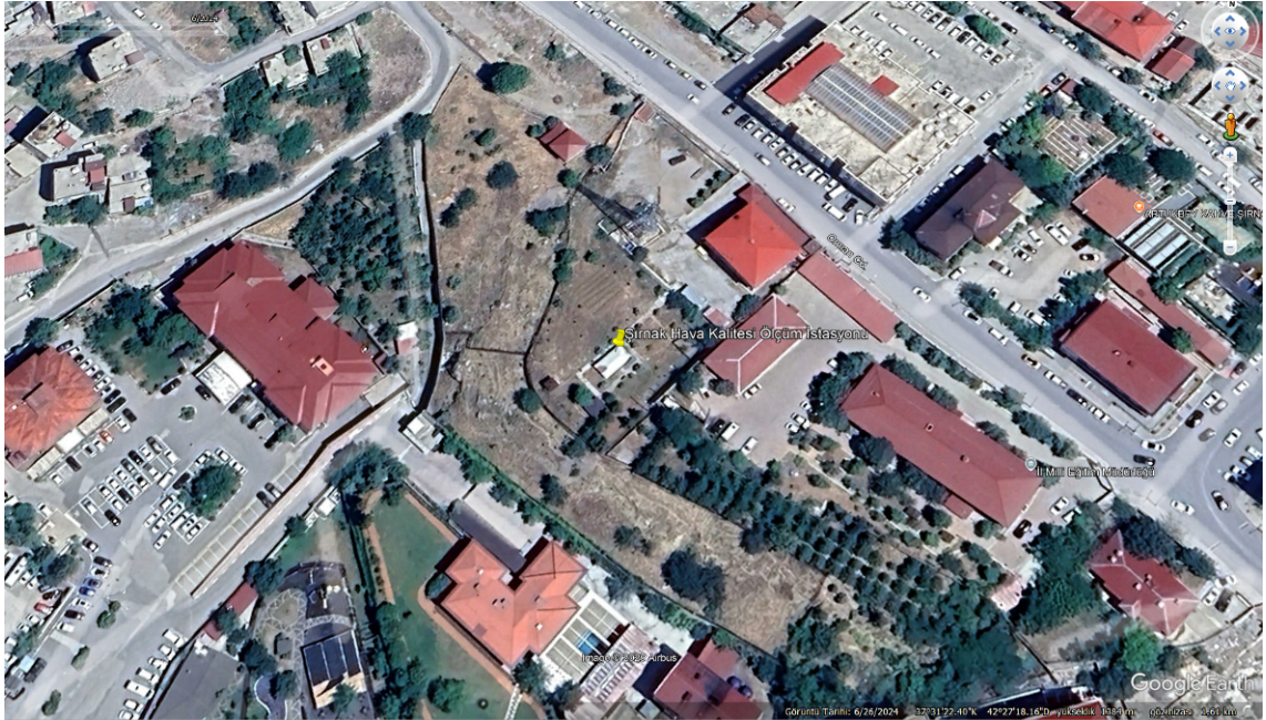
Şekil 4.34. Şırnak Hava Kalitesi Ölçüm İstasyonu
