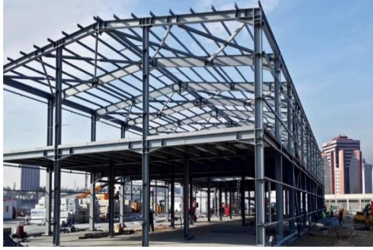
Şekil 1.1. Yapı mühendisliğinde kullanılan ince cidarlı taşıyıcı elemanlar
