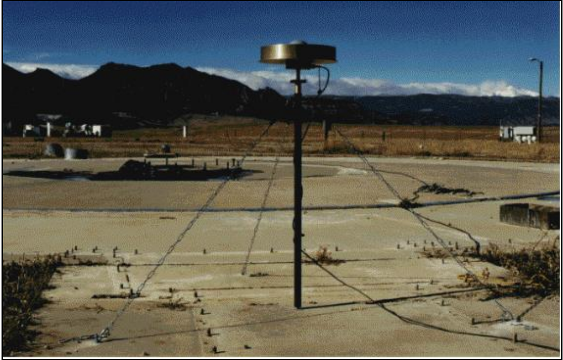
Şekil 3.11. Unavcoya ait bir Tech 200 Kurulumu (URL-4)
