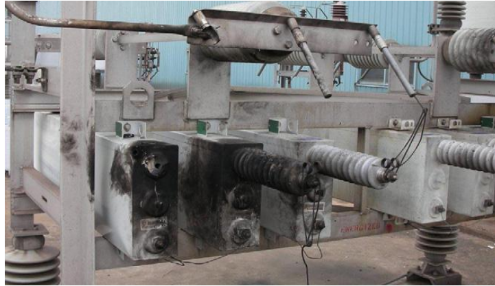
Şekil 5. 4 2. Harmonik filtrenin hasarlı kapasitör birimleri[10].
