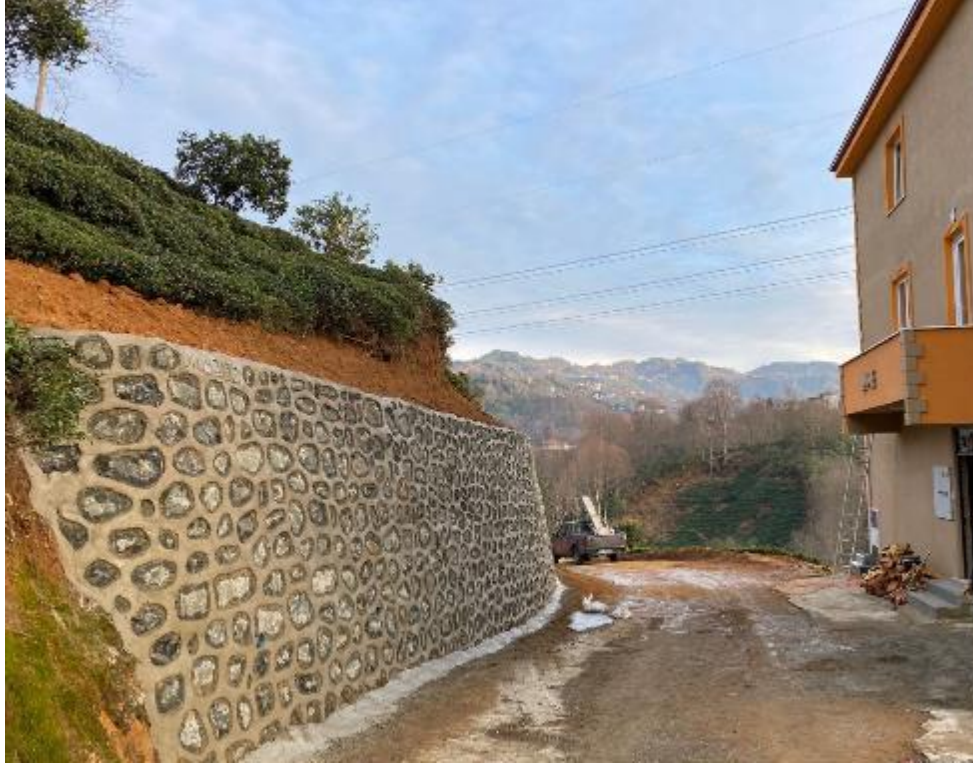
Şekil 1. Kabartma derz tekniği kullanılarak yapılan ağırlık tipi harçlı moloz taş duvar uygulaması
