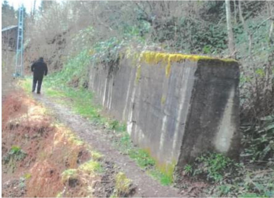
Şekil 3. Yarı ağırlık dayanma duvarı uygulaması
