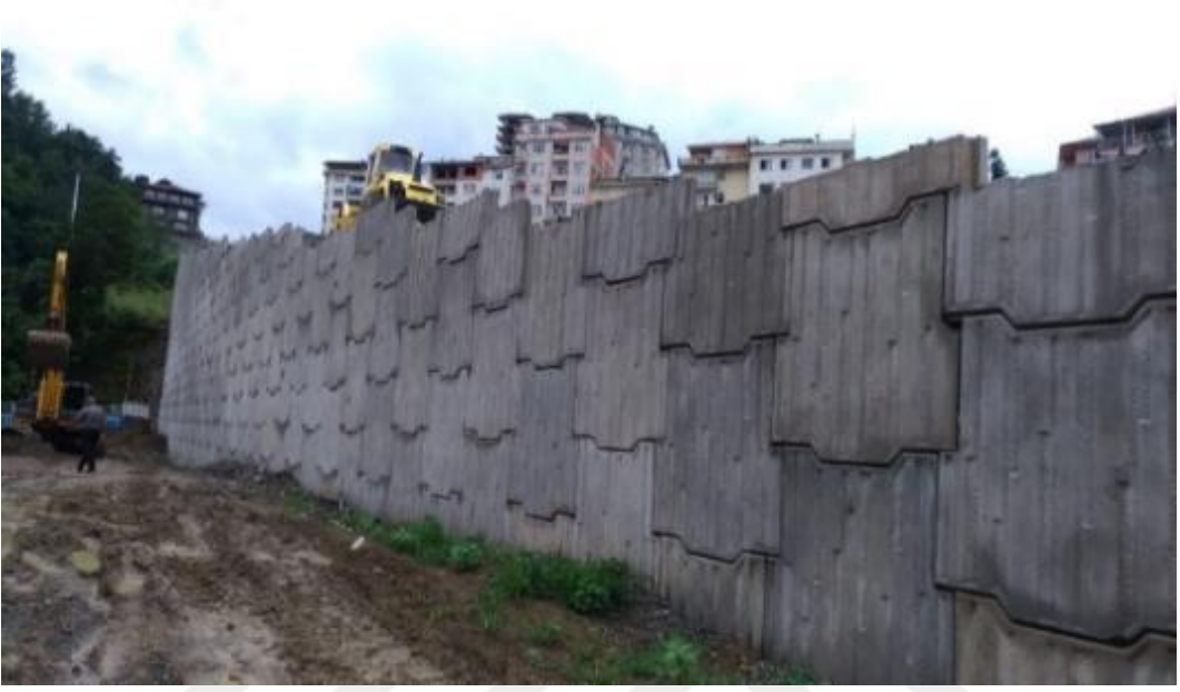
Şekil 14. Donatılı zemin duvar imalatı
