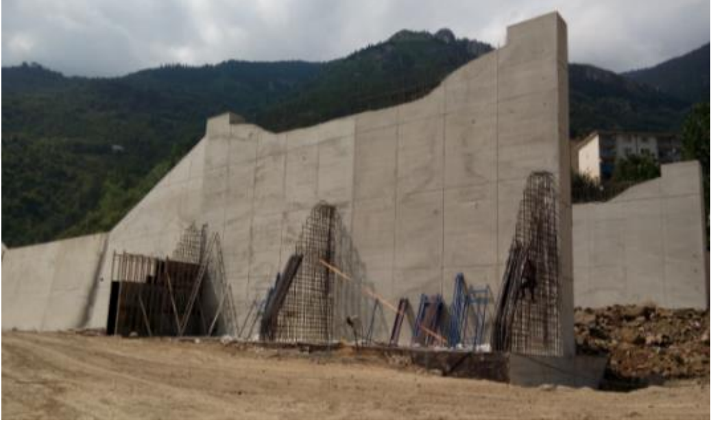
Şekil 7. Payandalı dayanma duvarı uygulaması
