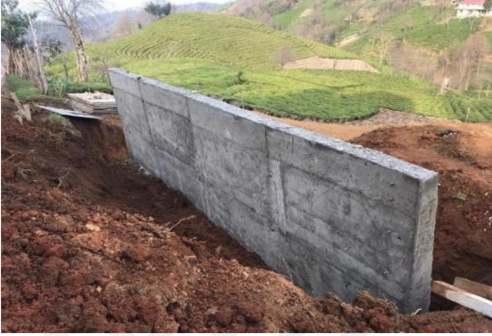
Şekil 5. Konsol dayanma duvarı uygulaması
