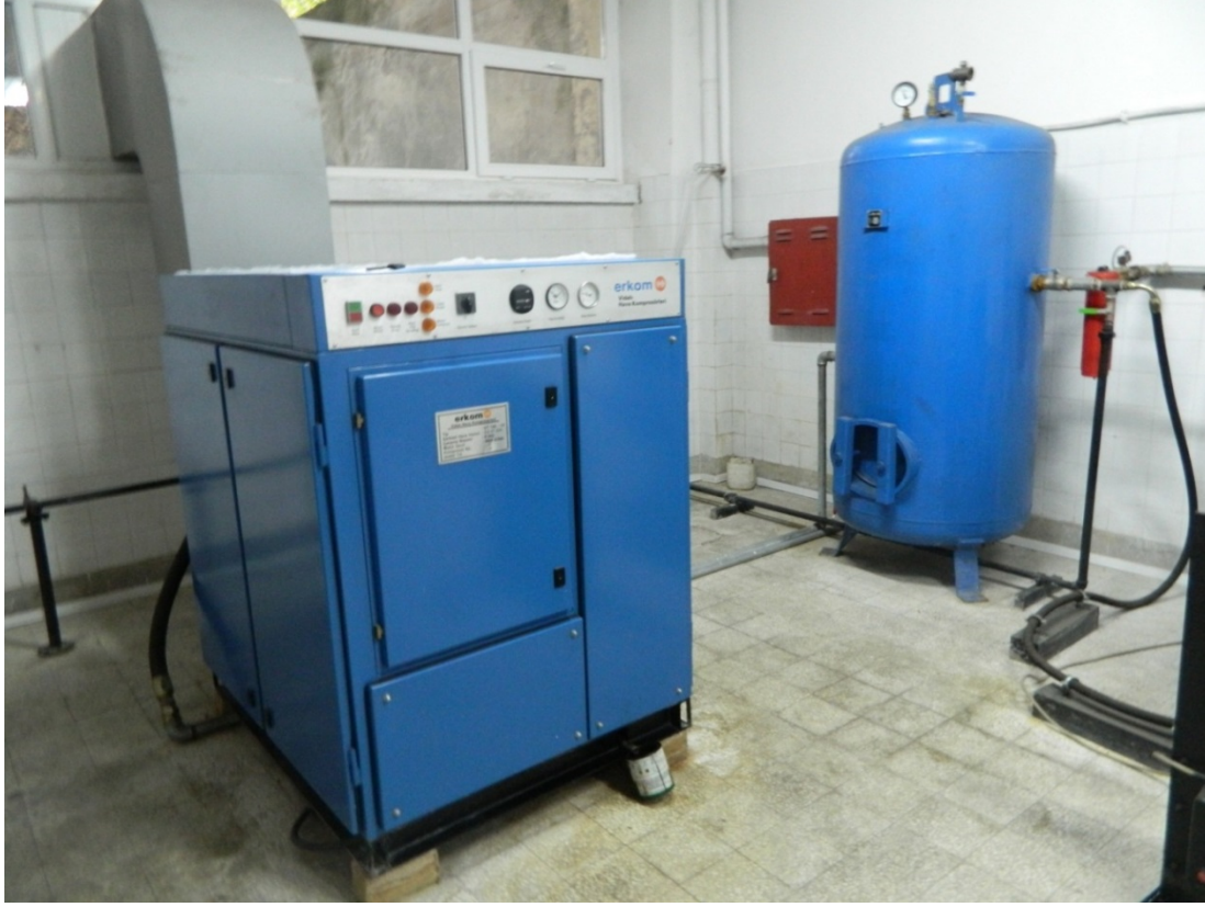
Şekil 4.4 : Vidalı hava kompresörü ve basınç tankı.
