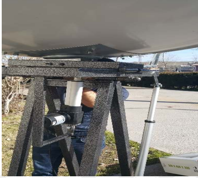
Şekil 5. SMGTS montaj çalışmaları
