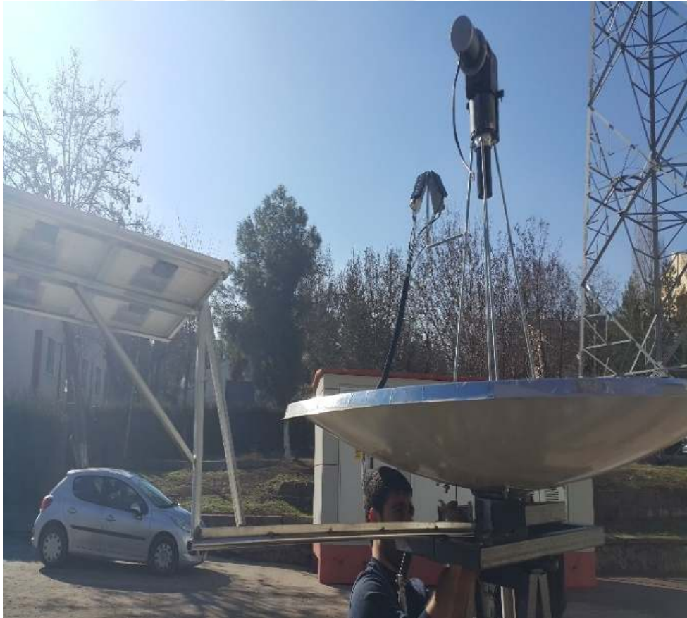
Şekil 4. SMGTS montaj çalışmaları
