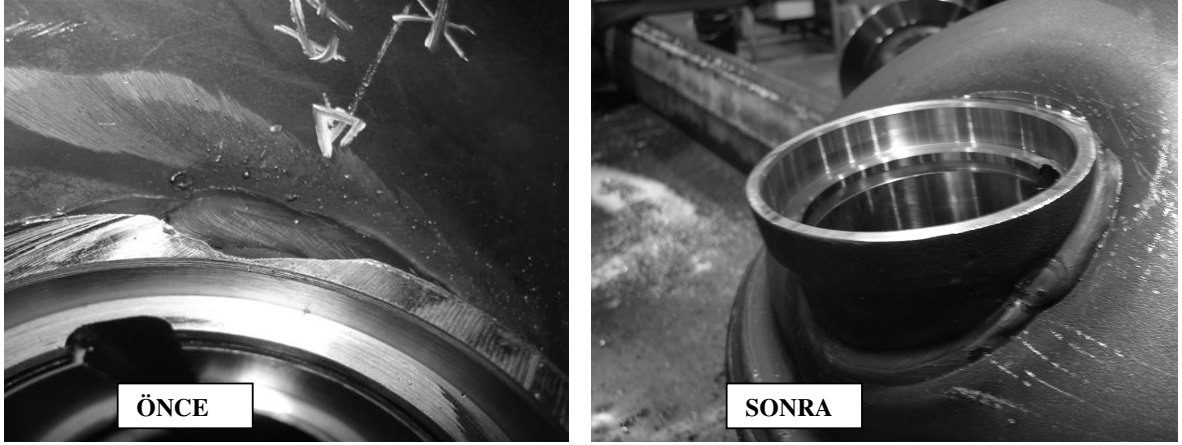
Şekil 25. Kaynak işlemi iyileştirme önce ve sonrası
