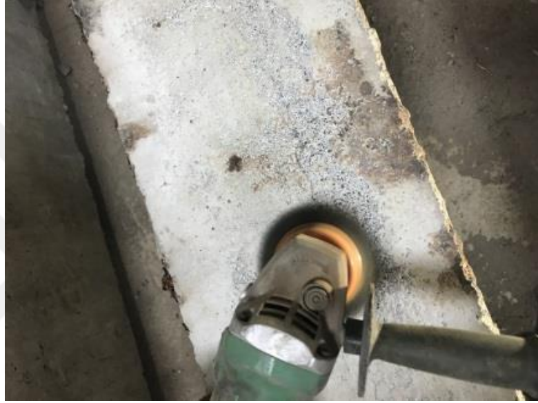
Şekil 4.21. FRP malzemesi yapılmadan betonarme kirişin yüzey temizliği
