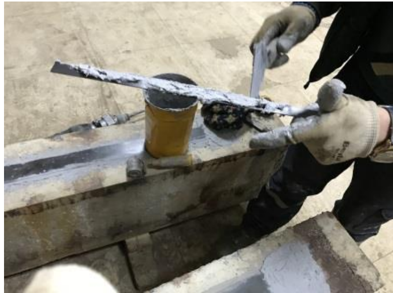
Şekil 4.22. FRP malzemesinin sikadur 30 ile kirişe yapıştırılması
