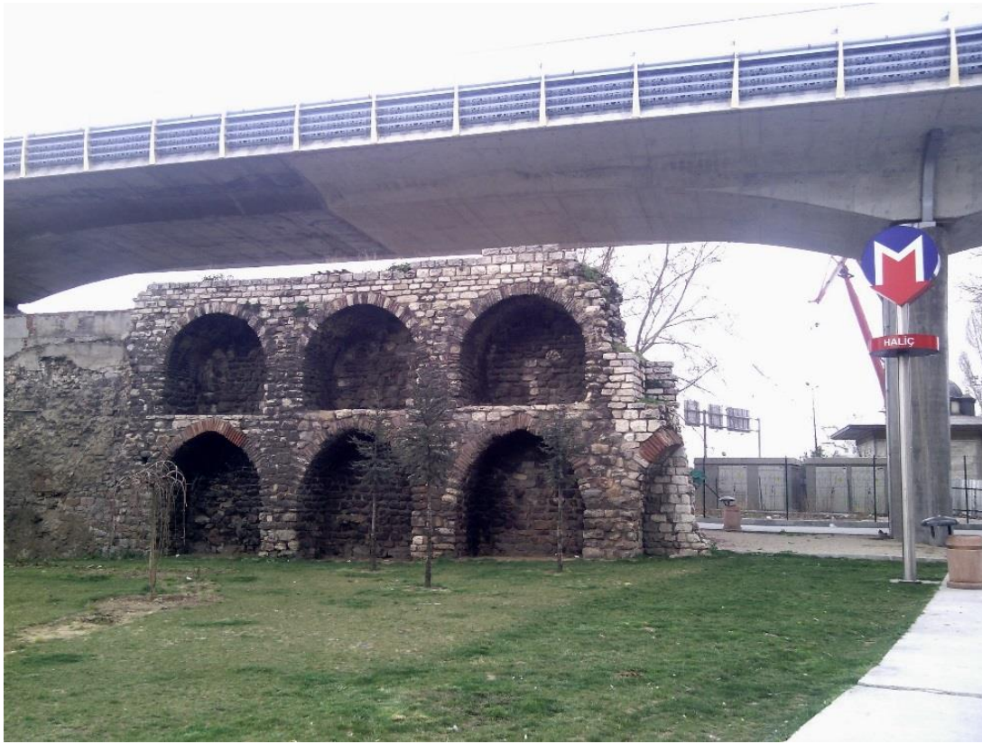
Şekil 3.45 : Yeni Haliç Metro Köprüsü ve Ceneviz Sur Kalıntıları, (Küblü, Y. 2015)
