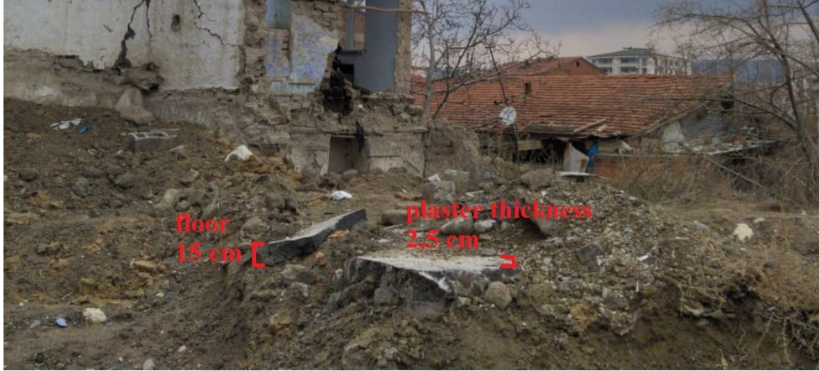
Figure 4.7 Sürsürü district– Sürsürü-2 conversion area demolition works
