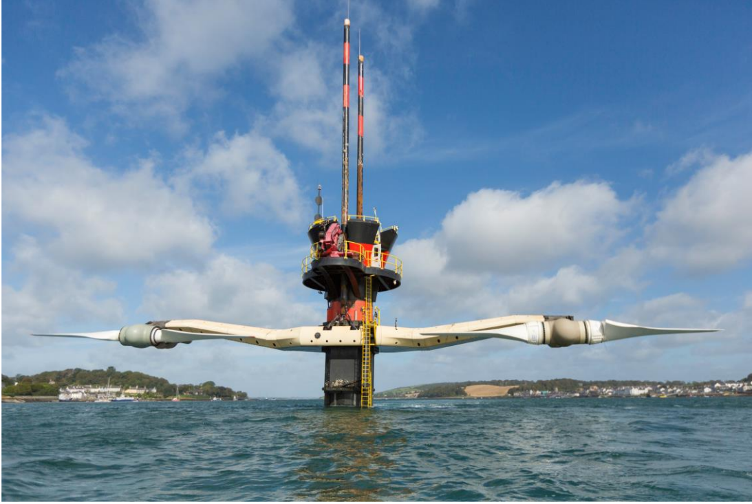
Şekil 1.2 : İki 1.2MW çift kanatlı yatay eksenli sualtı akıntı türbini (Url-2).
