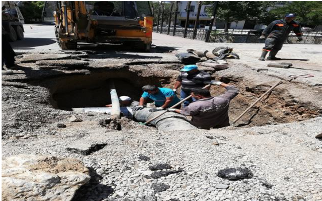
Şekil 4.28.30.07.2021 tarihinde ø450 mm çapında hdpe boru arıza çalışması
