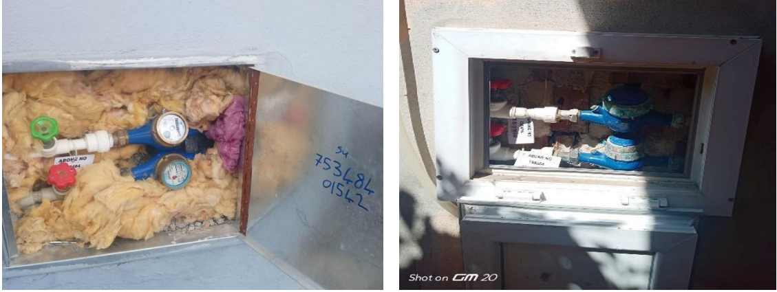
Şekil 4.14.Uygun sayaç yerleri resimleri
