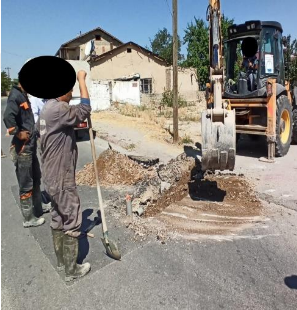
Şekil 4.18.DMA-1 vana bulma çalışması
