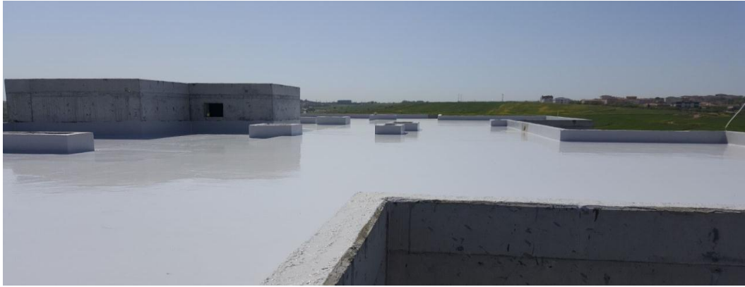
Şekil 3.9. Poliüretan esaslı sürme yalıtım uygulaması – Nidapark-Kayaşehir / İstanbul
