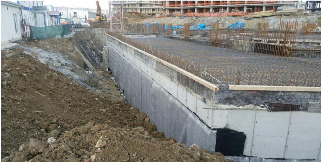
Şekil 4.30. Karat 34 F blok B.A. perde yalıtım uygulaması
