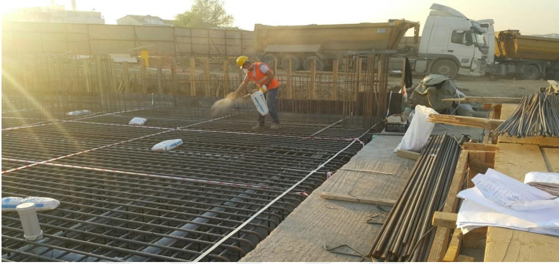
Şekil 4.18. Katkı malzemesinin serpiştirilerek uygulaması
