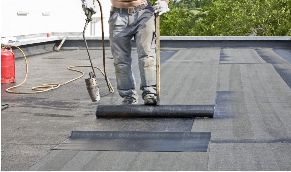
Şekil 3.4. TPO membran uygulaması (URL-10,2018).
