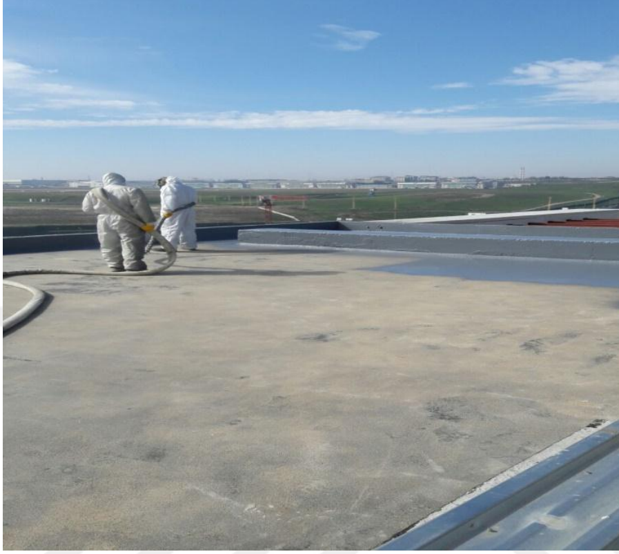
Şekil 3.10. Poliüretan esaslı püskürtme yalıtım uygulaması – Karat 34 / İstanbul
