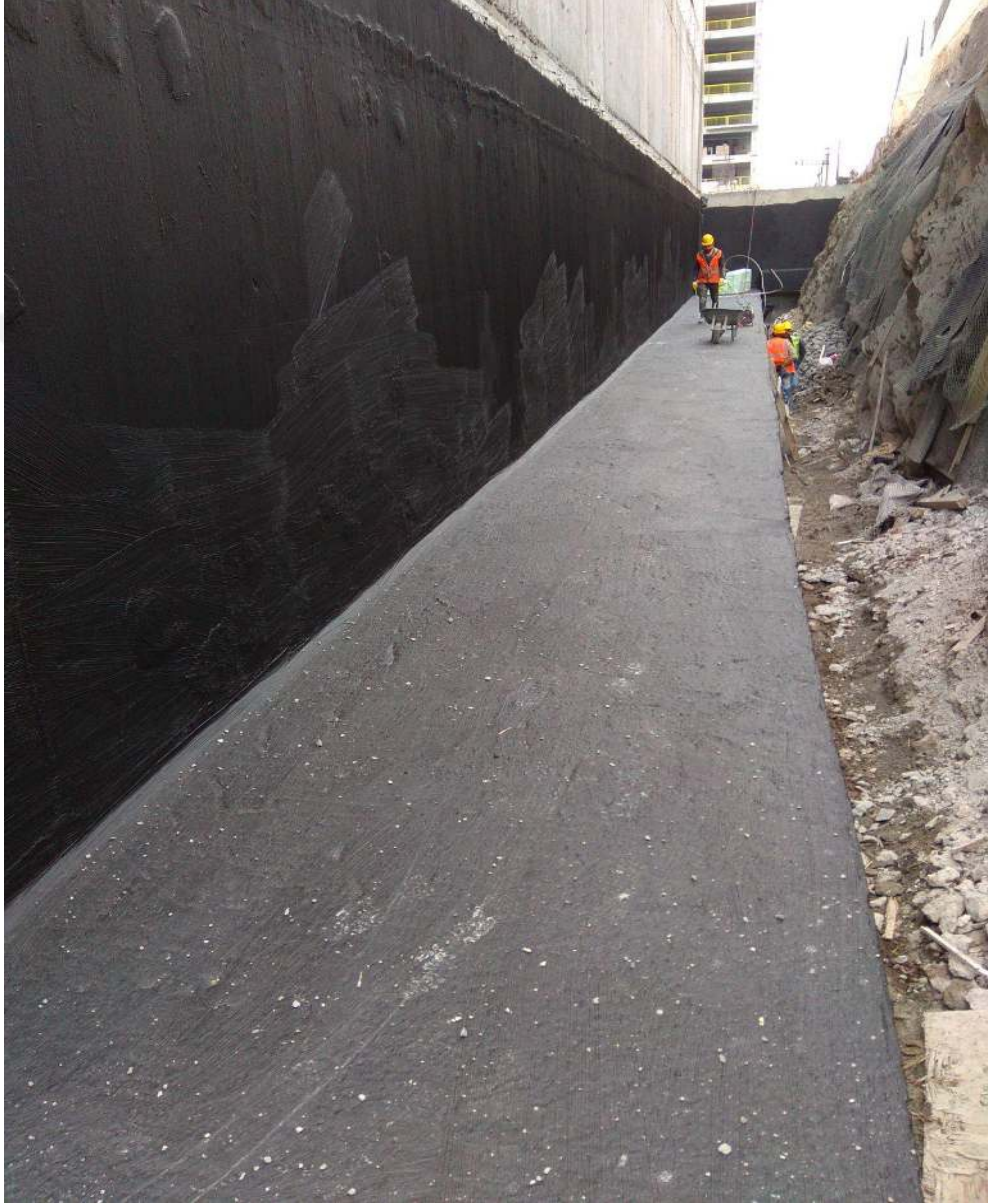
Şekil 4.20. Sürme esaslı bitüm kauçuk malzeme ile perdede yalıtım yapılması
