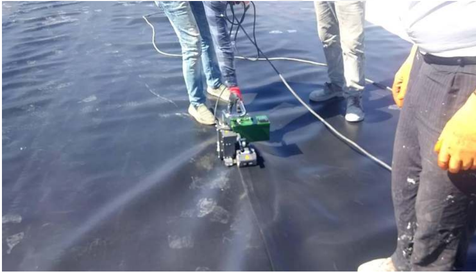
Şekil 3.5. EPDM membran uygulaması (URL-10,2018).
