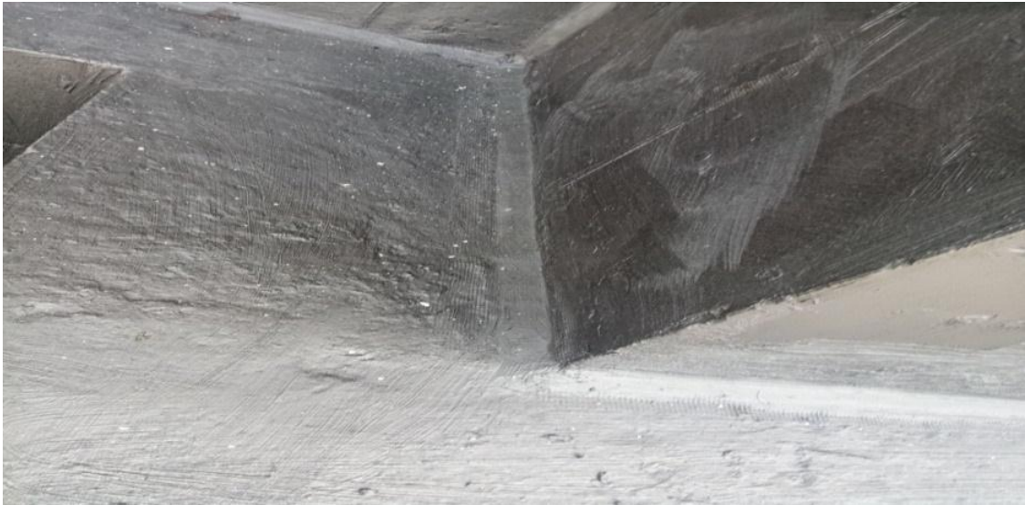
Şekil 4.19. Soğuk derzde fileli tamir harcıyla pah yapılması
