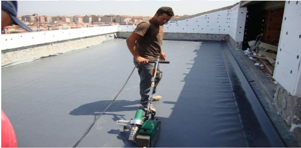
Şekil 3.3. PVC membran uygulaması (URL-10,2018).
