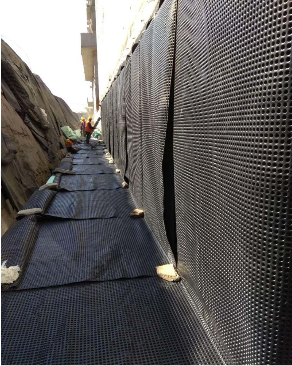
Şekil 4.22. HDPE esaslı drenaj levhası serilmesi
