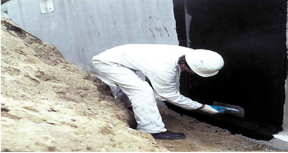
Şekil 3.7. Bitüm esaslı sürme tip yalıtım uygulaması
