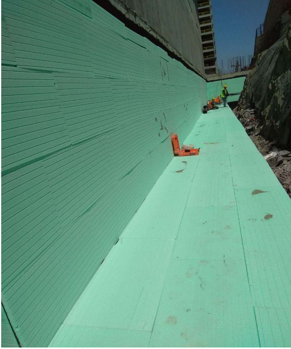
Şekil 4.21. Yalıtım üzerine XPS serilmesi
