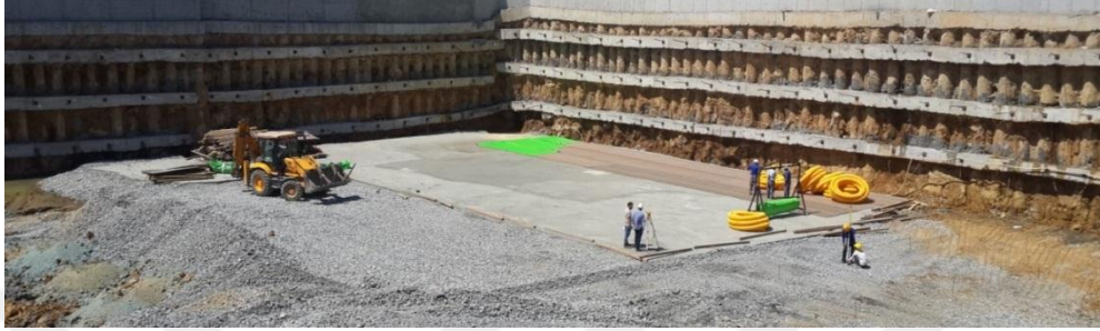
Şekil 3.6. Bentonit esaslı geomembran uygulaması - 34 İnn projesi İstanbul
