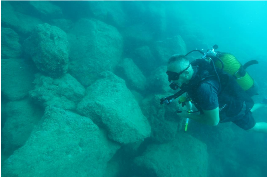
Resim 53: Sualtı mendirek yapısı
