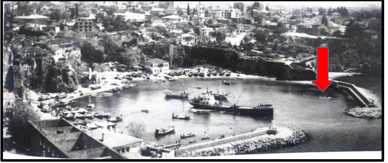
Resim 11: Güney Deniz burcu yıkıldıktan sonra satıhta görülen kısmı
