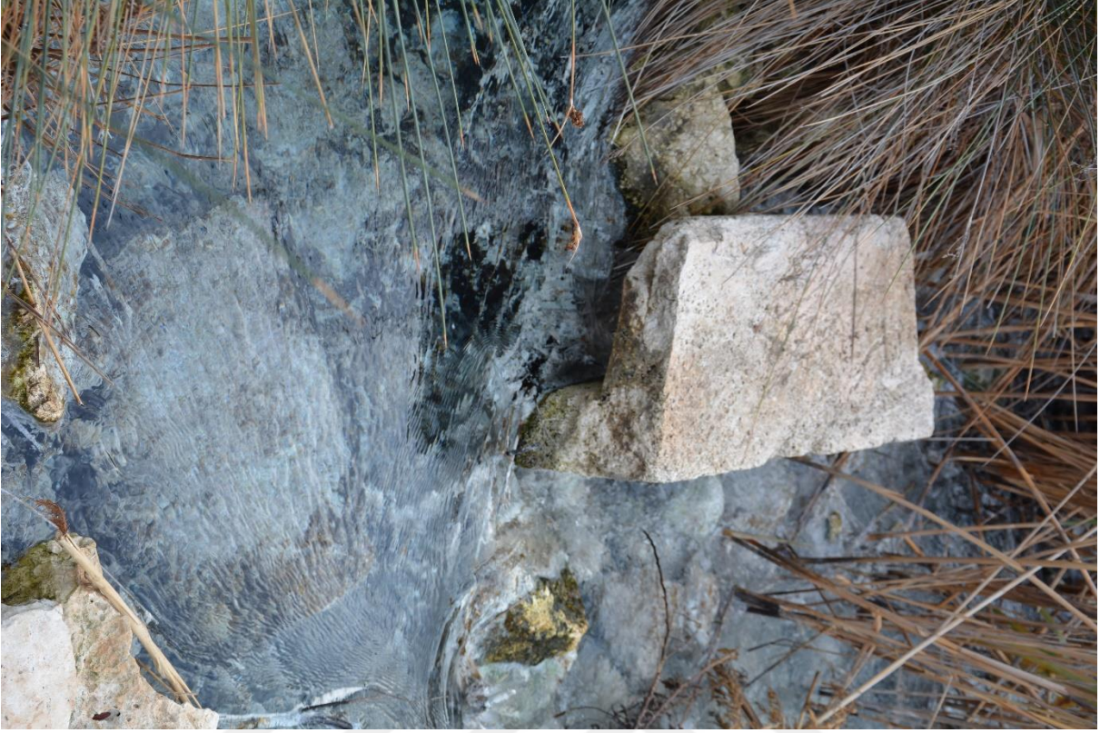
(a) Su Kaynağı Su Yolu.
