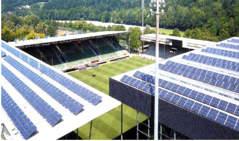
Resim 5.1. Almanya Freiburg, Futbol sahasının çatısında uygulanan güneş panelleri
