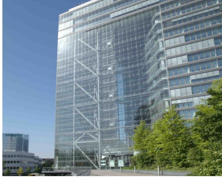
Şekil 4.46 Stadttor Binası genel görünüm (Stadttor.de)
