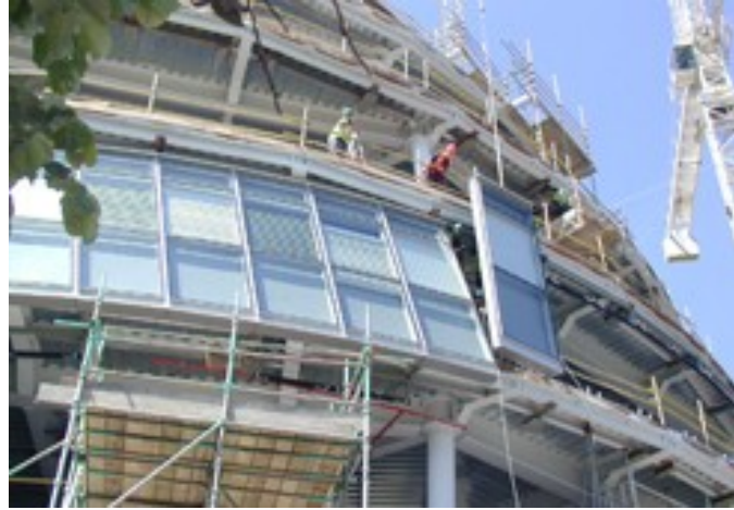
Şekil 4.17 Parlamento Binası yapım aşaması (London.gov.uk)
