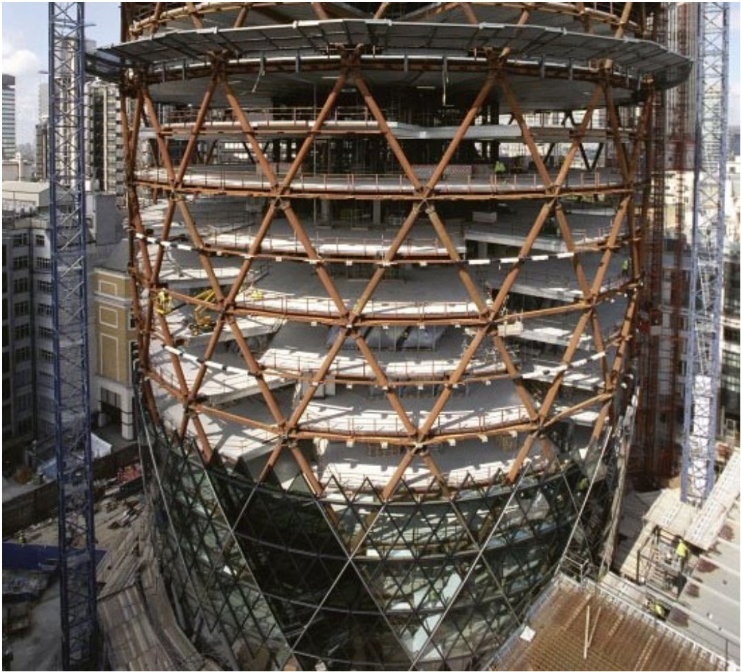
Şekil 4.22 Swiss Re Binası çelik dış çerçeve yapım aşaması (Constructalia.com)
