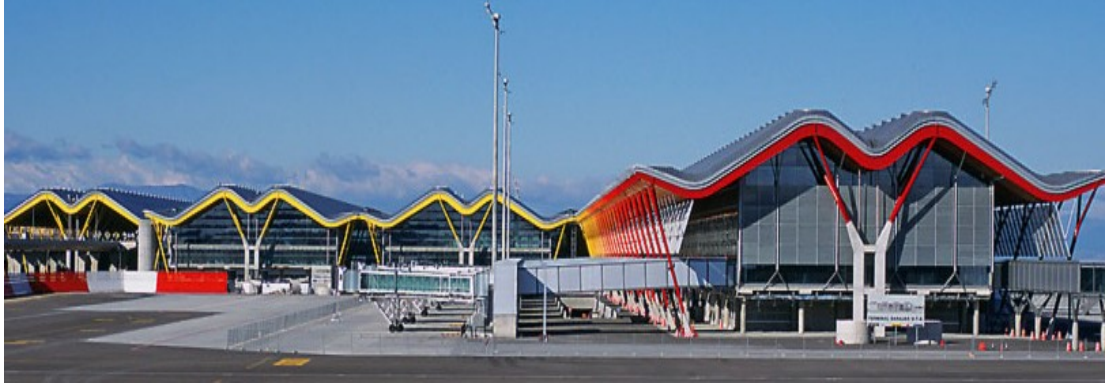
Şekil 4.1 Barajas Havalimanı genel görünüm (Rogers Stirk Harbour + Partners)
