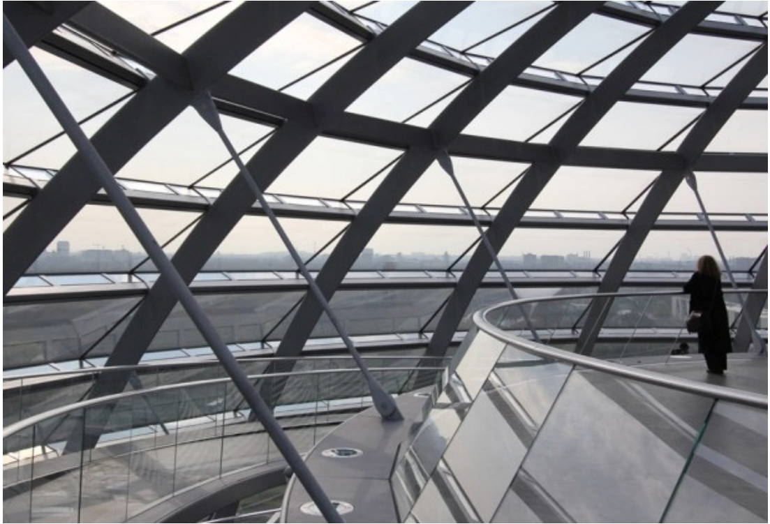
Şekil 4.63 Reichstag Parlamento Binası kubbe strüktür sistemi (greatbuildings.com)
