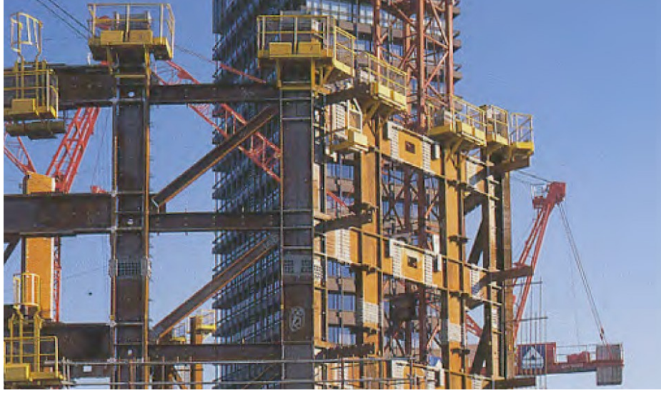
Şekil 4.44 Commerzbank Binası çelik strüktür sistemi (Benkert)
