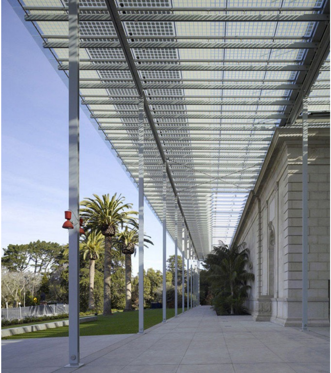
Şekil 4.34 Kaliforniya Bilim Akademisi çatı saçağı ve çelik kolonlar (Archdaily.com, 2008)
