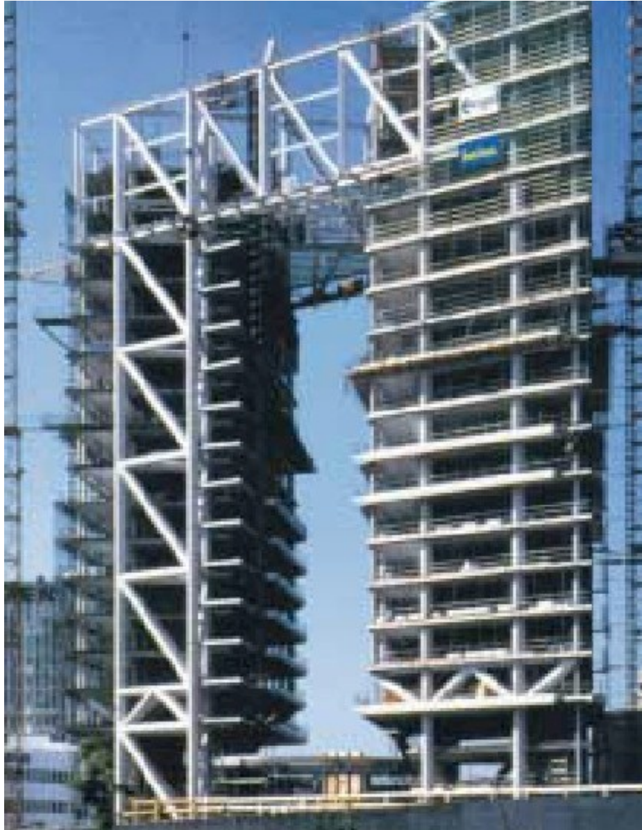
Şekil 4.51 Stadttor Binası çelik taşıyıcı sistem (Stadttor.de)
