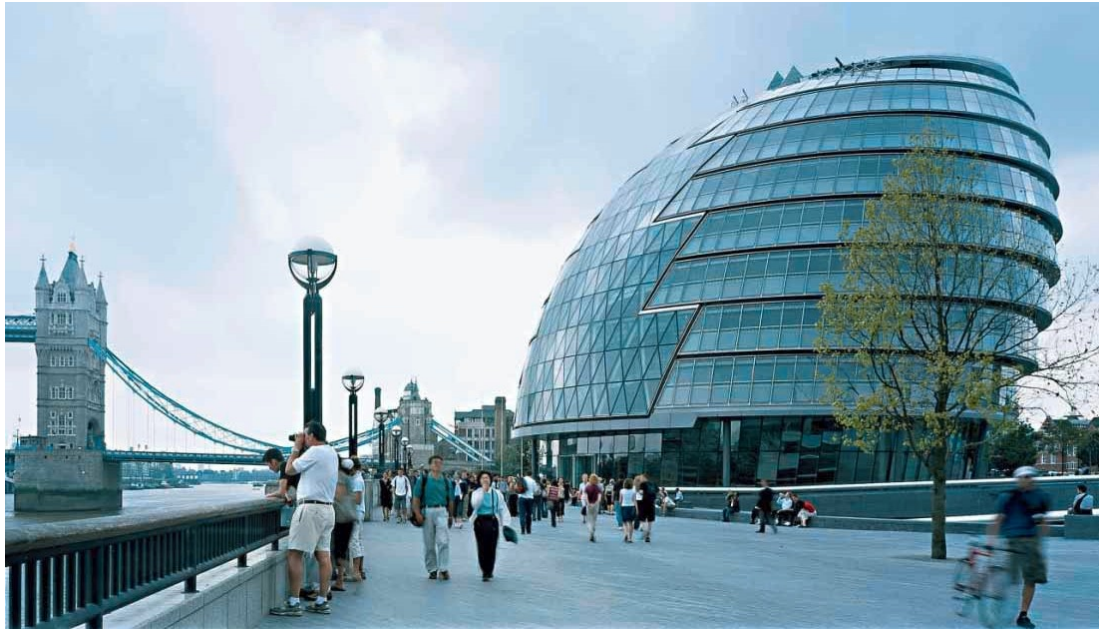
Şekil 4.11 Parlamento Binası genel görünüm (Merkel, 2003)
