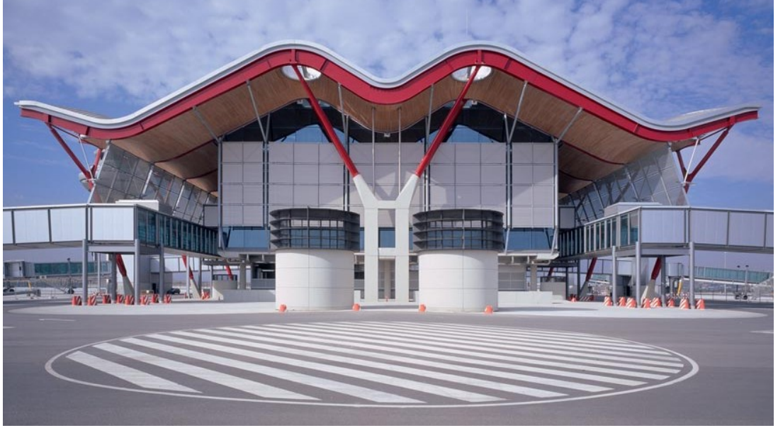
Şekil 4.3 Barajas Havalimanı çatı örtüsü (Rogers Stirk Harbour + Partners)
