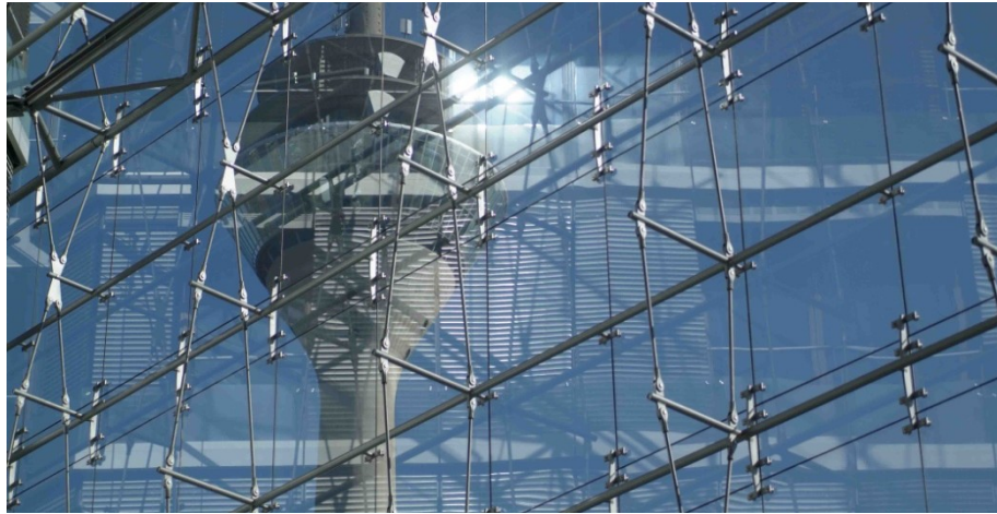
Şekil 4.50 Stadttor Binası atrium cephe sistem detayı (Stadttor.de)
