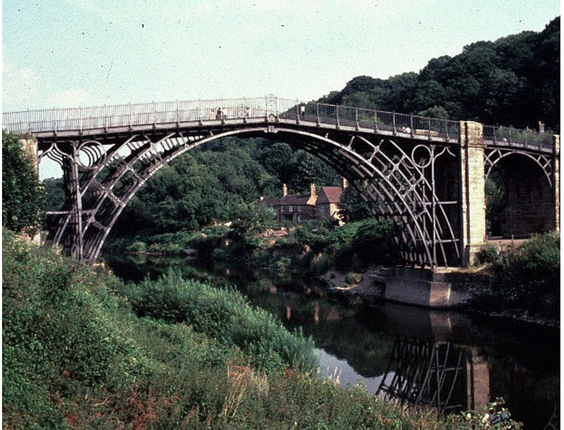
Şekil 3.1 Coalbrookdale Köprüsü, 1778, İngiltere (GreatBuildings.com)
