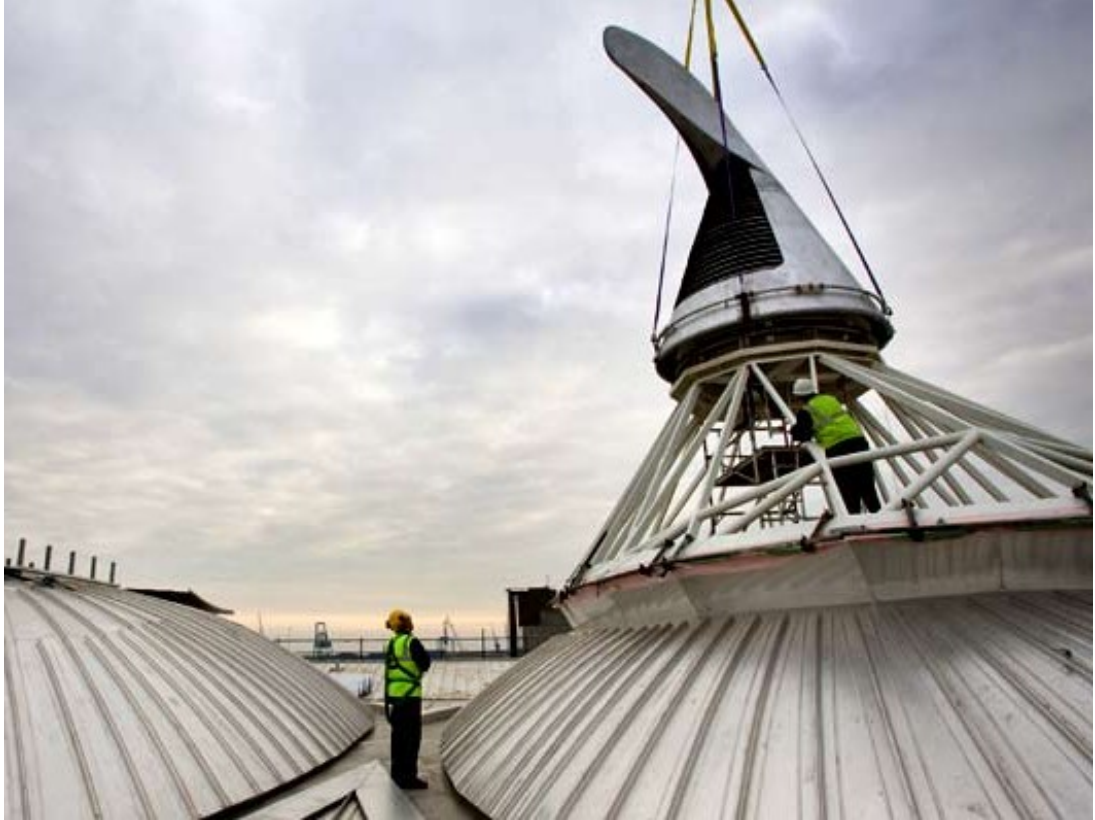
Şekil 4.57 Galler Parlamento Binası çatı pencersi ve üst başlık (Rogers Stirk Harbour + Partners)
