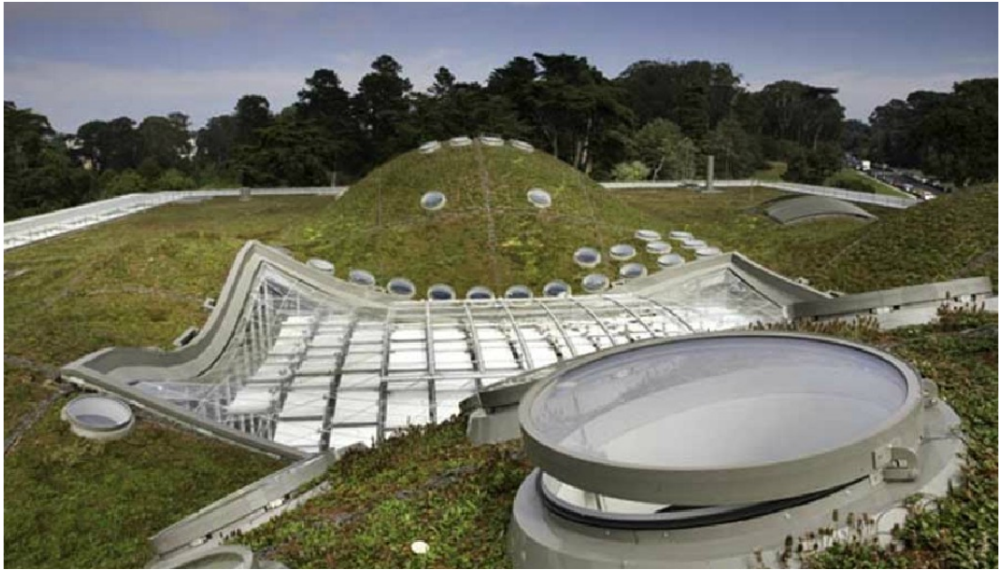
Şekil 4.30 Kaliforniya Bilim Akademisi eğrisel çatı genel görünüm (Renzo Piano Building Workshop)
