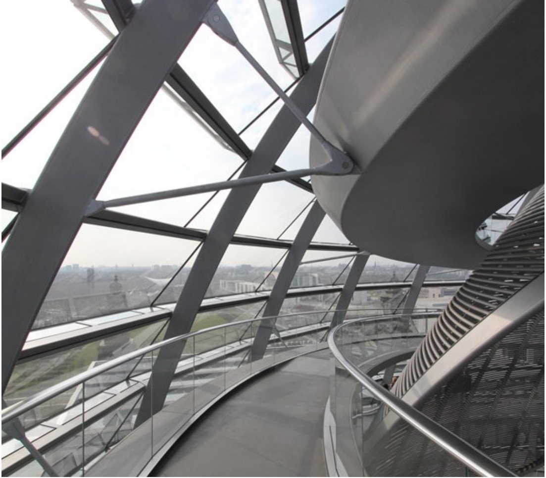
Şekil 4.66 Reichstag Parlamento Binası çelik yapı elemanları (greatbuildings.com)
