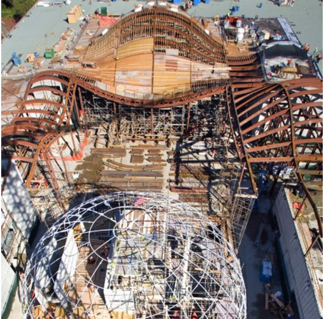
Şekil 4.31 Kaliforniya Bilim Akademisi eğrisel çatı çelik strüktür (Arup.com)
