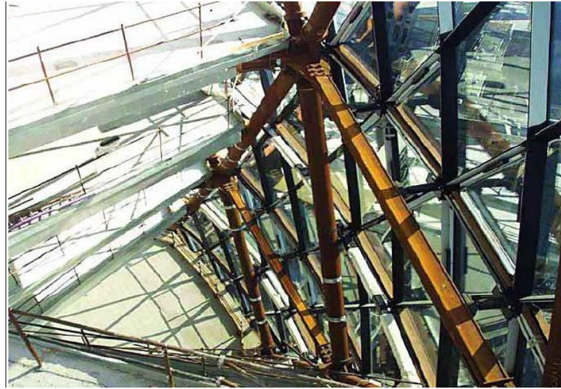
Şekil 4.21 Swiss Re Binası atrium yapım aşaması (Constructalia.com)
