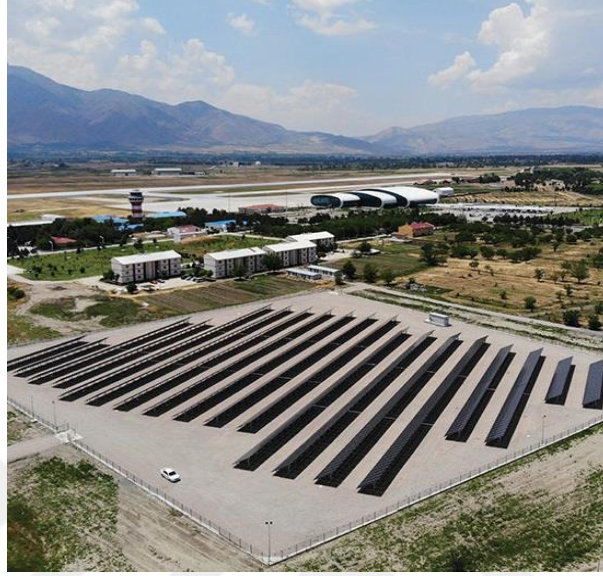
Şekil 2.4. Erzincan Havalimanı Güneş Enerjisi Santrali (http-4).
