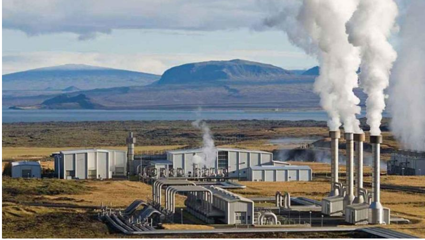
Şekil 2.4. Jeotermal Enerji Santrali (Anonim 2022e)
