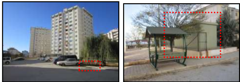
Şekil 4.136. Çalışma alanındaki teknik alt yapıya ilişkin örnekler
