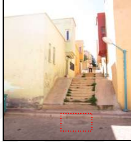
Şekil 4.191. Çalışma alanındaki teknik alt yapıya ilişkin örnekler
