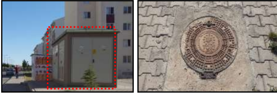
Şekil 4.18. Çalışma alanındaki teknik alt yapıya ilişkin örnekler
