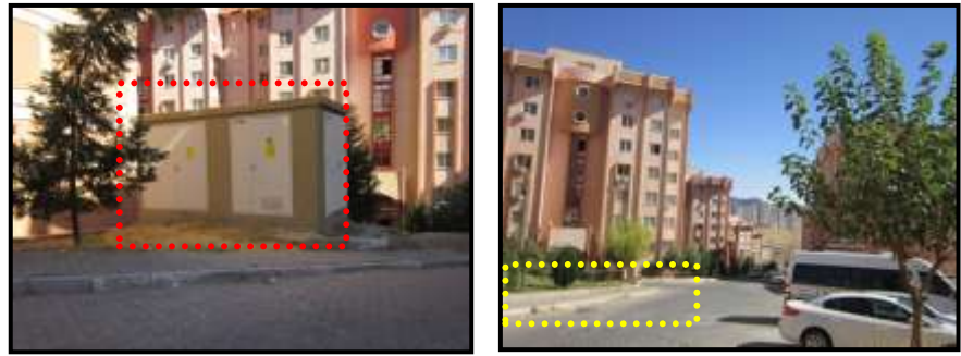
Şekil 4.76. Çalışma alanındaki teknik alt yapıya ilişkin örnekler
