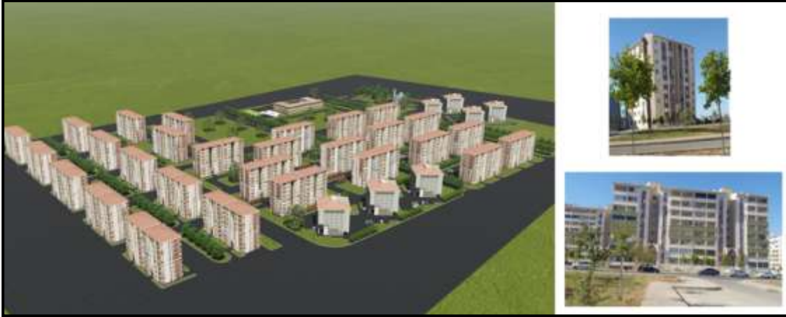
Şekil 4.25. Çalışma alanında bloklar
