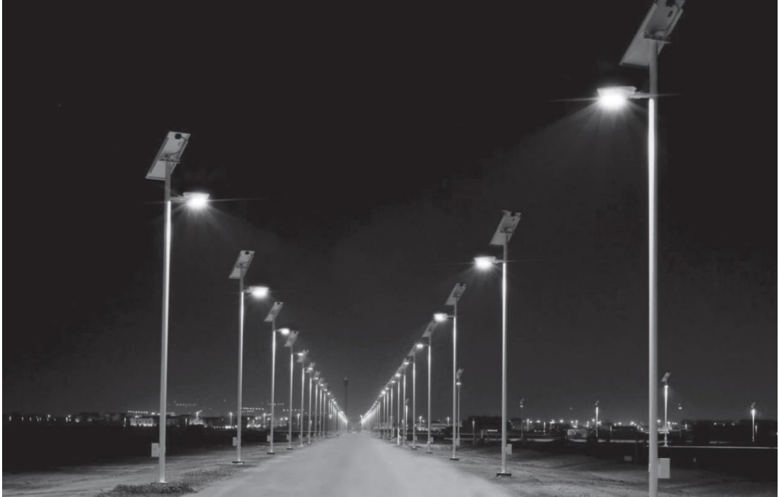
Şekil 8.5: Güneş Enerjisi Aydınlatma Direği Örneği ( http://pelsan.com.tr , 2018)
