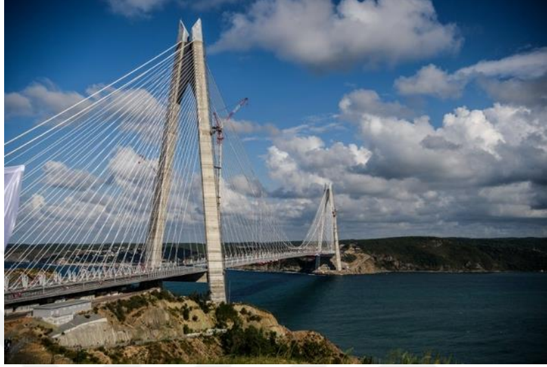
Şekil 6.1: 3. Boğaz Köprüsü ( https://megaprojeleristanbul.com , 2018)
