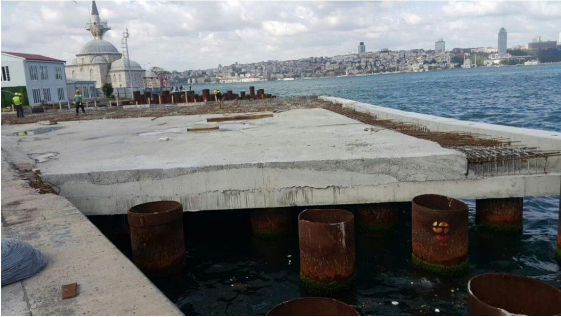
Şekil 7.5: Üsküdar Meydan İnşaatı
