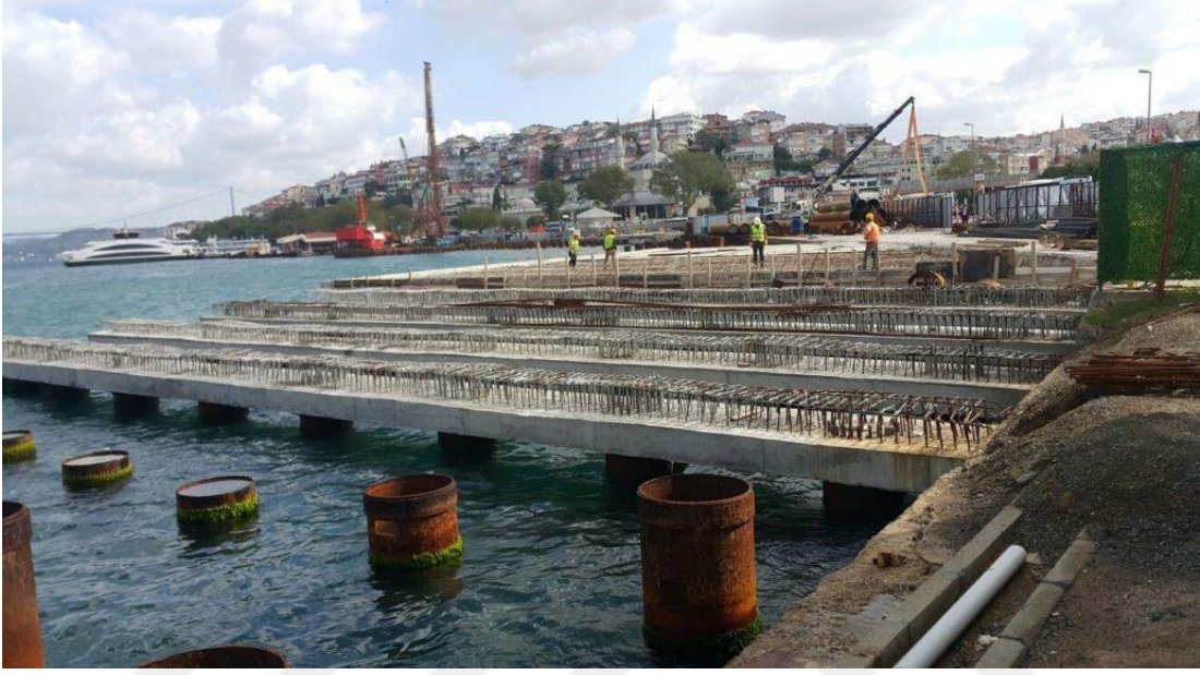
Şekil 7.4: Üsküdar Meydan İnşaatı
